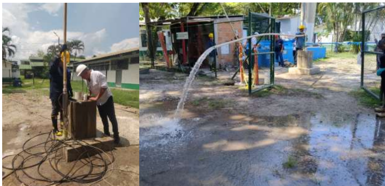
Ilustración 2 Detalle prueba de bombeo y colocación de la bomba sumergible para prueba.
