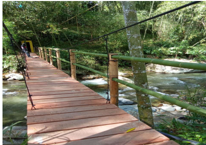
Fotografías 9-10. Instalación de platinas de refuerzo y módulos de tablero chanul. Fuente: Contratista.
