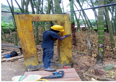
Fotografías 14-15. Restauración pintura resistente al agua. Fuente: Contratista.
