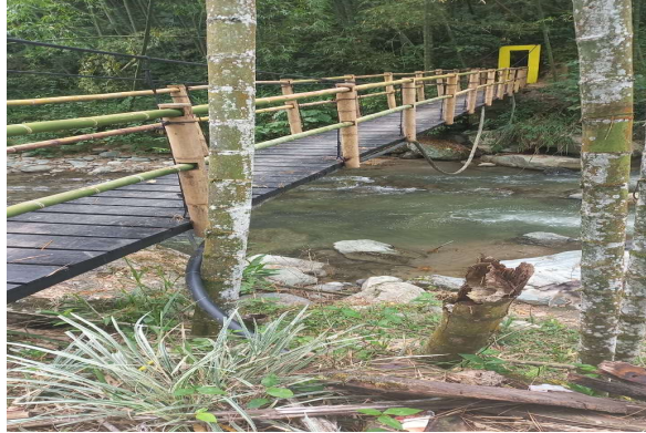
Fotografía 41. Visita de supervisión al puente – Verificación de obra terminada. Fuente: Supervisión Municipio de Córdoba Quindío.
