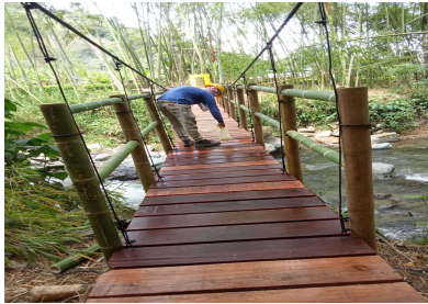
Fotografías 26-27. Inmunización tablero chanul. Fuente: Contratista.
