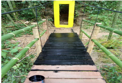
Fotografía 40. Pintura protección frente al agua Fuente: Contratista.
