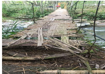
Fotografías 3-4. Deterioro de tableros y elementos de guadua. Fuente: Contratista.
