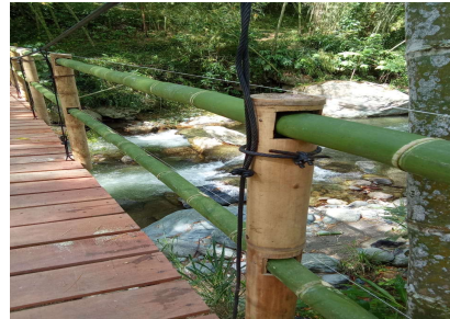
Fotografías 9-10. Instalación de platinas de refuerzo y módulos de tablero chanul. Fuente: Contratista.
