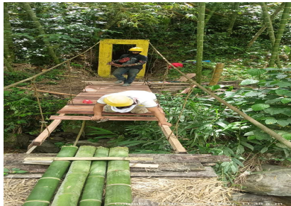
Fotografías 3-4. Deterioro de tableros y elementos de guadua. Fuente: Contratista.
