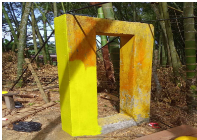
Fotografías 18-19. Restauración pintura resistente al agua. Fuente: Contratista.
