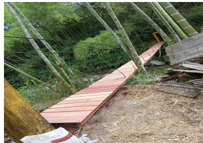
Fotografías 6-7. Desmante de estructura de piso y tirantes laterales. Fuente: Contratista.
