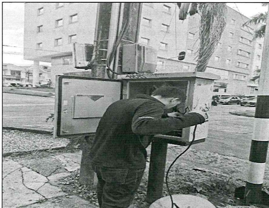
Imagen 52: Registro fotografico del mantenimiento correctivo interseccion semaforica sector clínica Cardiovascular 27 de marzo de 2026
