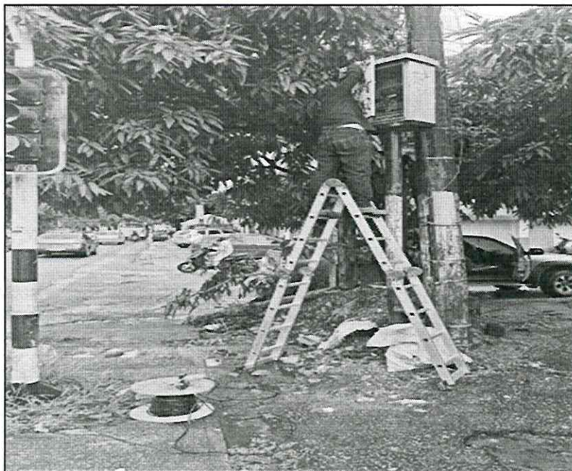
Imagen 46: Registro fotografico del mantenimiento correctivo interseccion semaforica colegio Bachillerato Femenino 23 de marzo 2026
