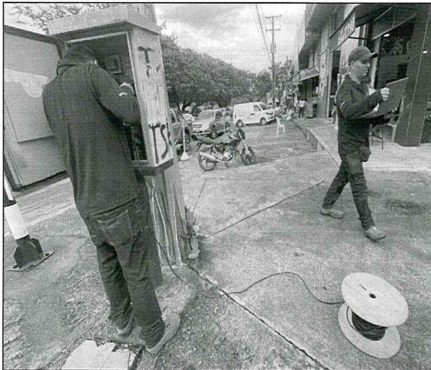
Imagen 49: Registro fotografico del mantenimiento correctivo interseccion semaforica sector carnes Danny 25 de marzo 2026
