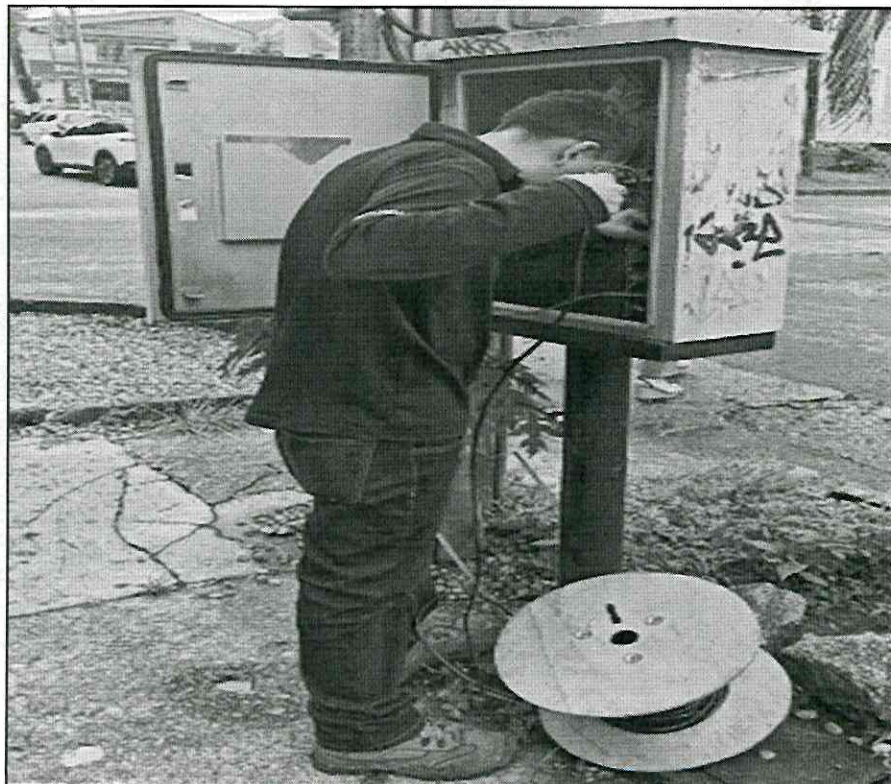
Imagen 53: Registro fotografico del mantenimiento correctivo interseccion semaforica sector Clínica Cardiovascular 27 de marzo de 2026
