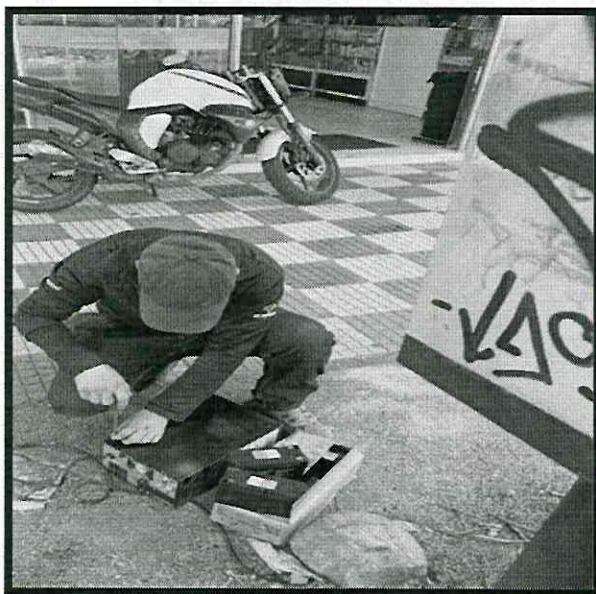
Imagen 39: Registro fotografico del mantenimiento correctivo remanso Carrera 16 X Calle 15: Del 9 al 13 de marzo de marzo de 2026
