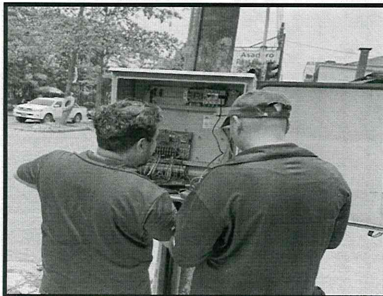
Imagen 44 : Registro fotografico del mantenimiento correctivo villa Johana Carrera 7 X Calle 15: Del 9 al 13 de marzo de 2026
