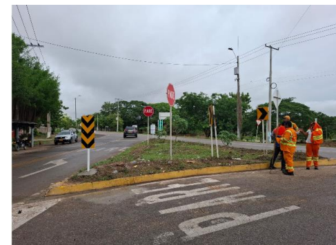
INSTALACIÓN SEÑALIZACIÓN VERTICAL MARCADOR DE OBSTÁCULO DOBLE SENTIDO 78BL02
