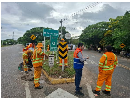
INSTALACIÓN SEÑALIZACIÓN VERTICAL MARCADOR DE OBSTÁCULO DOBLE SENTIDO 78BL02
