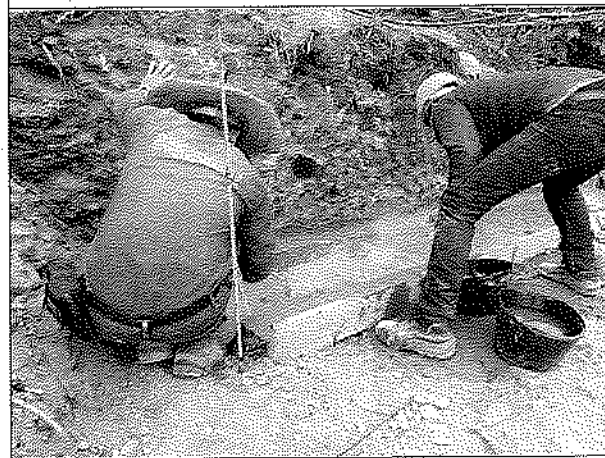
Elaboración de canaleta
