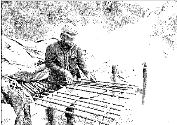
Suministro y colocacion acero de refuerzo fy 4200 kg/cm 2
