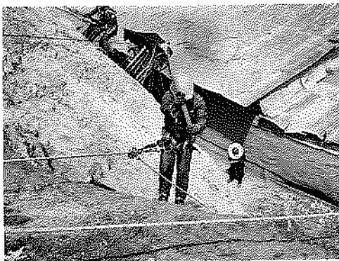
Perfilado a mano descolgada de Talud
