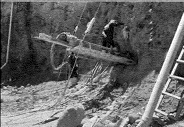
Sistema de abatimiento para perforación horizontal
