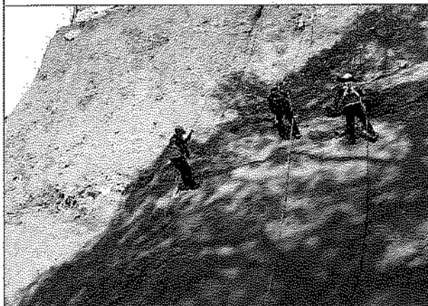
Perfilado a mano descolgado de talud
