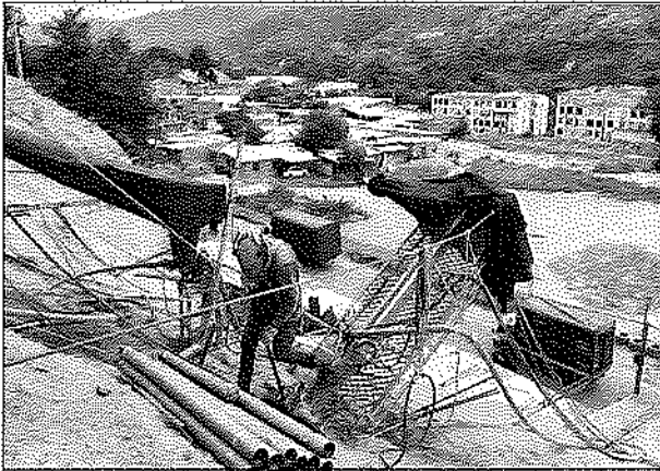
Ejecución perforación horizontal
