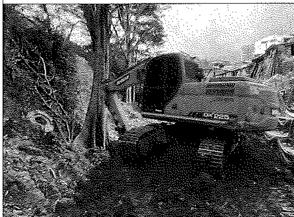
Excavación con acarreo libre
