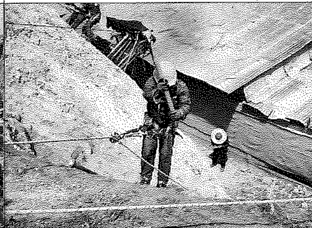
Perfilado a mano descolgado de talud
