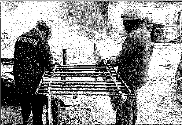
Suministro y colocación acero de refuerzo fy 4200 kg/cm 2
