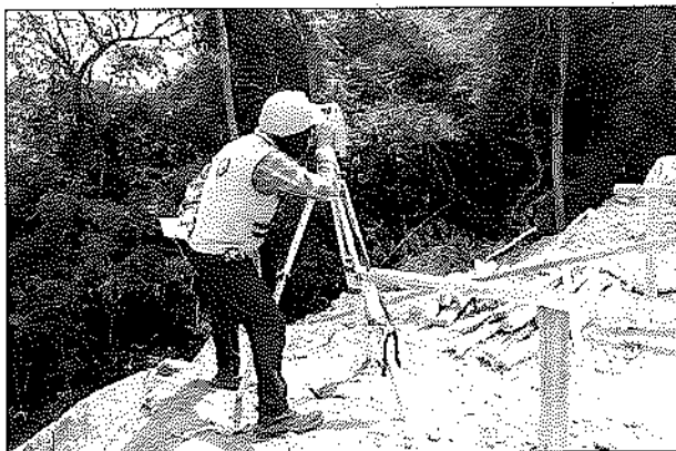
Replanteo, control y medición de la obra
