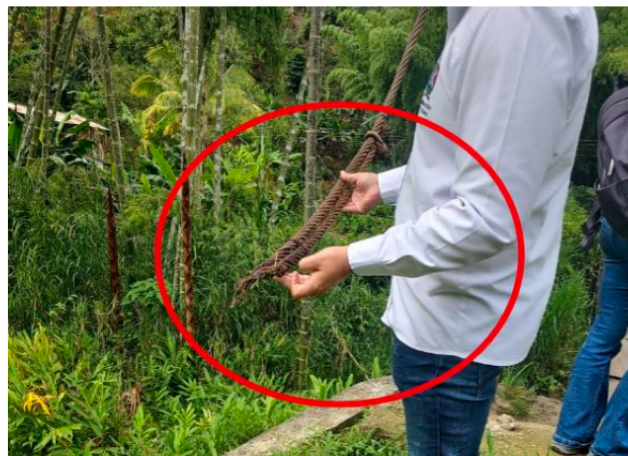
imagen 2/ Cable tensor lateral principal Fracturado
