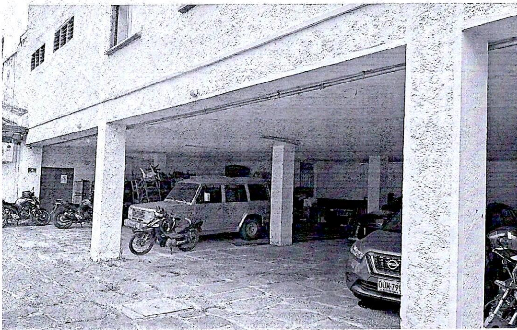
Imagen No. 4. Estado actual del parqueadero ubicado en el PALACIO MUNICIPAL.
