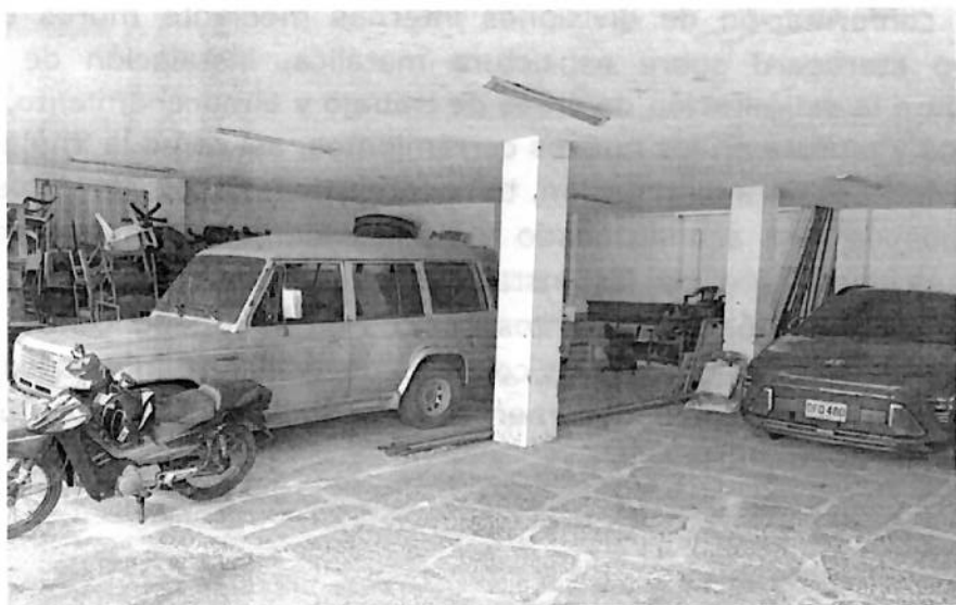
Imagen No. 5. Estado actual del parqueadero ubicado en el PALACIO MUNICIPAL.
