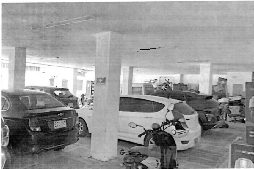
Imagen No. 3. Estado actual del parqueadero ubicado en el PALACIO MUNICIPAL.
