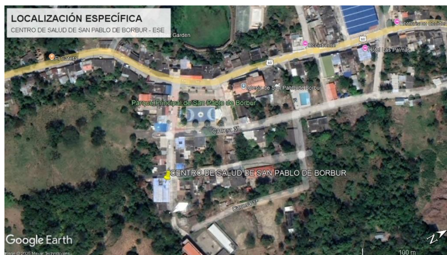
Ilustración 2. Localización específica del proyecto. Fuente: Google Earth.
