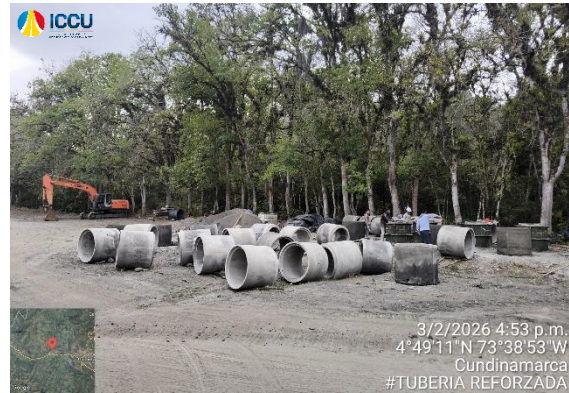
Construcción de tubería reforzada de 36"
