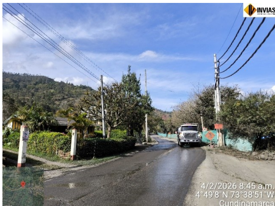
Humectación de vía para control de material particulado
