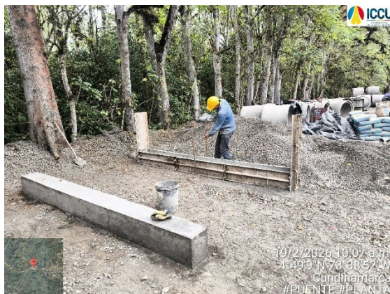
Construcción de burros para almacenamiento de acero de refuerzo
