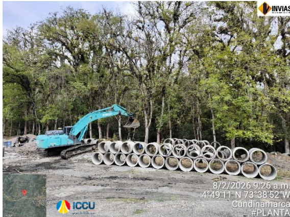
Construcción de tubería reforzada de 36"
