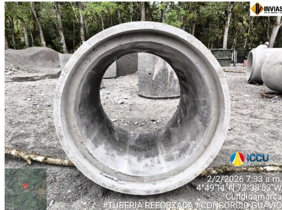
Construcción de tubería reforzada de 36"
