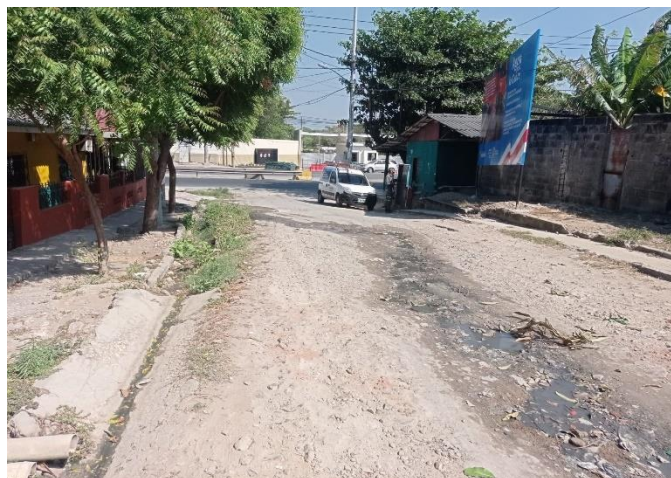
Foto No. 2 - Situación Actual vertimiento de aguas residuales en las calles.
