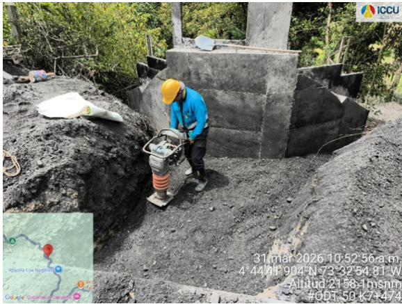
Relleno estructural de ODT-50 K7+474.68
