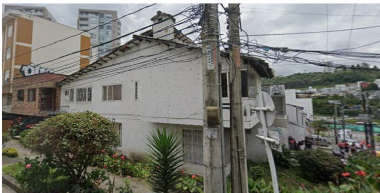
Figura 2. Vista Frontal Casa Laureles Manizales.
