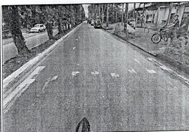
Imagen. cebra y flechas de dirección desgastadas
