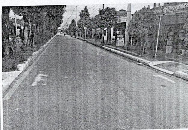
Imagen. cebra y flechas de dirección desgastadas
