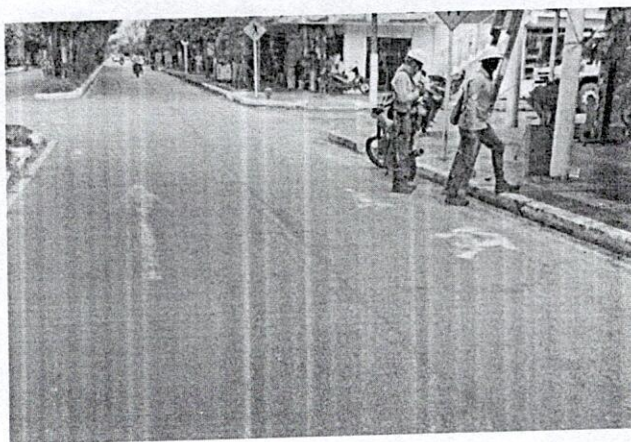
Imagen. cebra y flechas de dirección desgastadas
