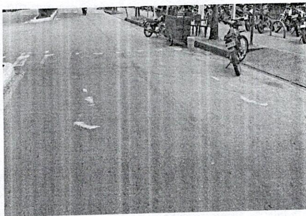
Imagen. cebra y flechas de dirección desgastadas
