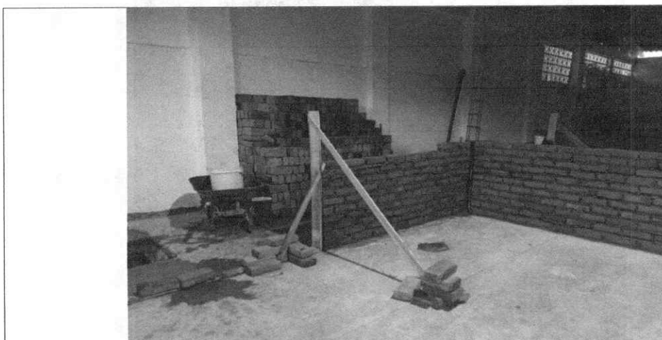
Ilustración 20 Muro ladrillo común
