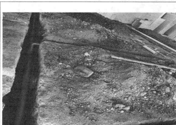
Ilustración 7 Excavación en conglomerado.
