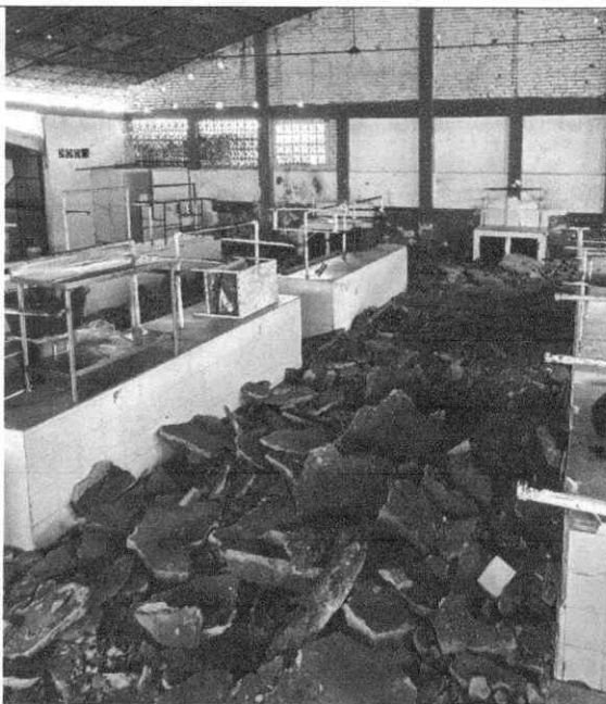
Ilustración 2 Demolición contrapiso existente.
