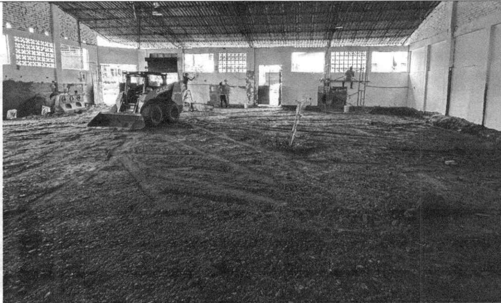
Ilustración 4 Relleno roca muerta compact
