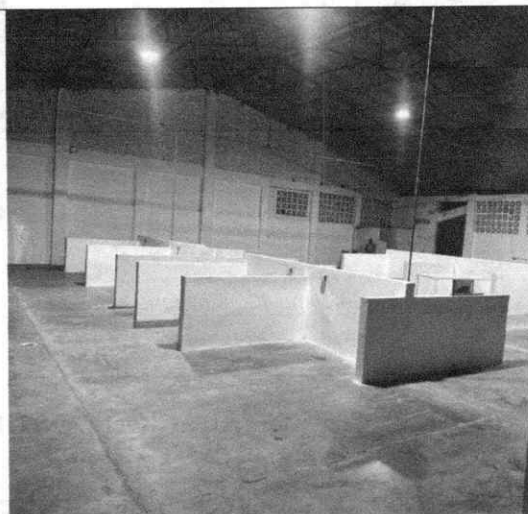
Ilustración 29 Suministro e instalación reflector led 200w
