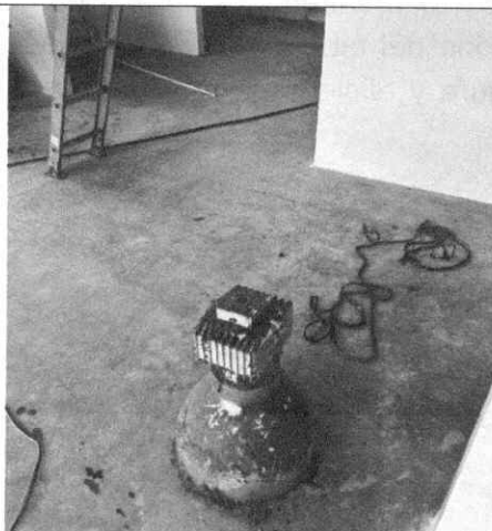
Ilustración 35 Desmonte de luminarias
