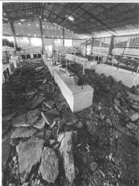
Ilustración 3 Demolición contrapiso existente.
