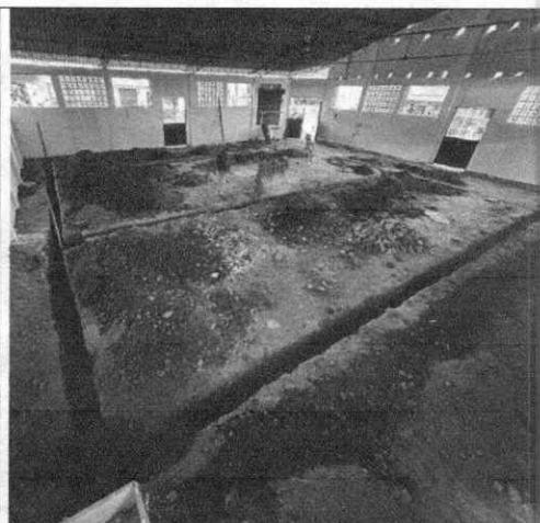
Ilustración 8 Excavación en conglomerado.
