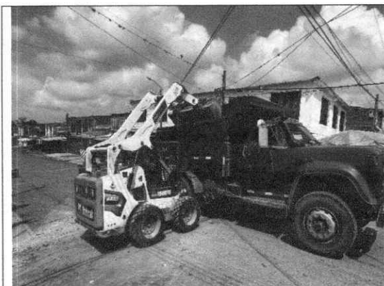
Ilustración 11 Retiro de material sobrante <= 10 km
