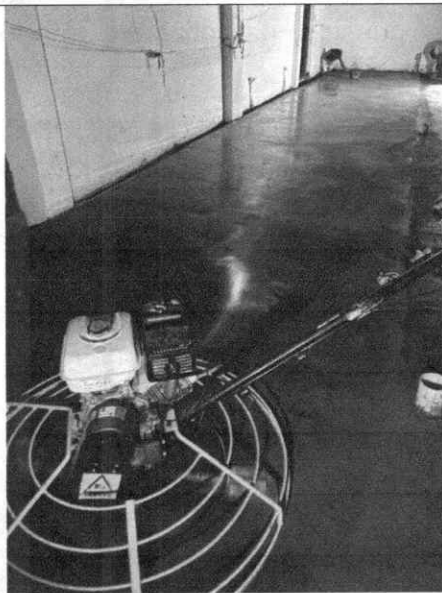
Ilustración 5 Piso en concreto pulido
