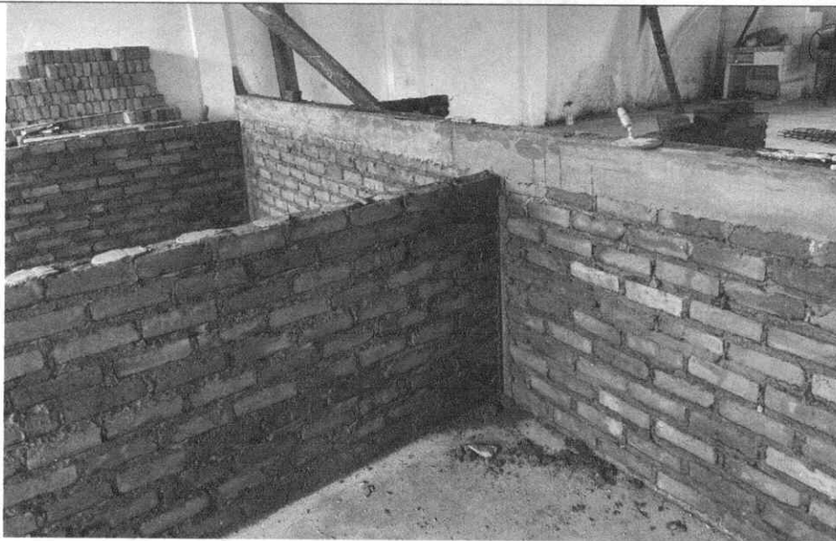
Ilustración 18 Viga concreto aérea 3000 psi
