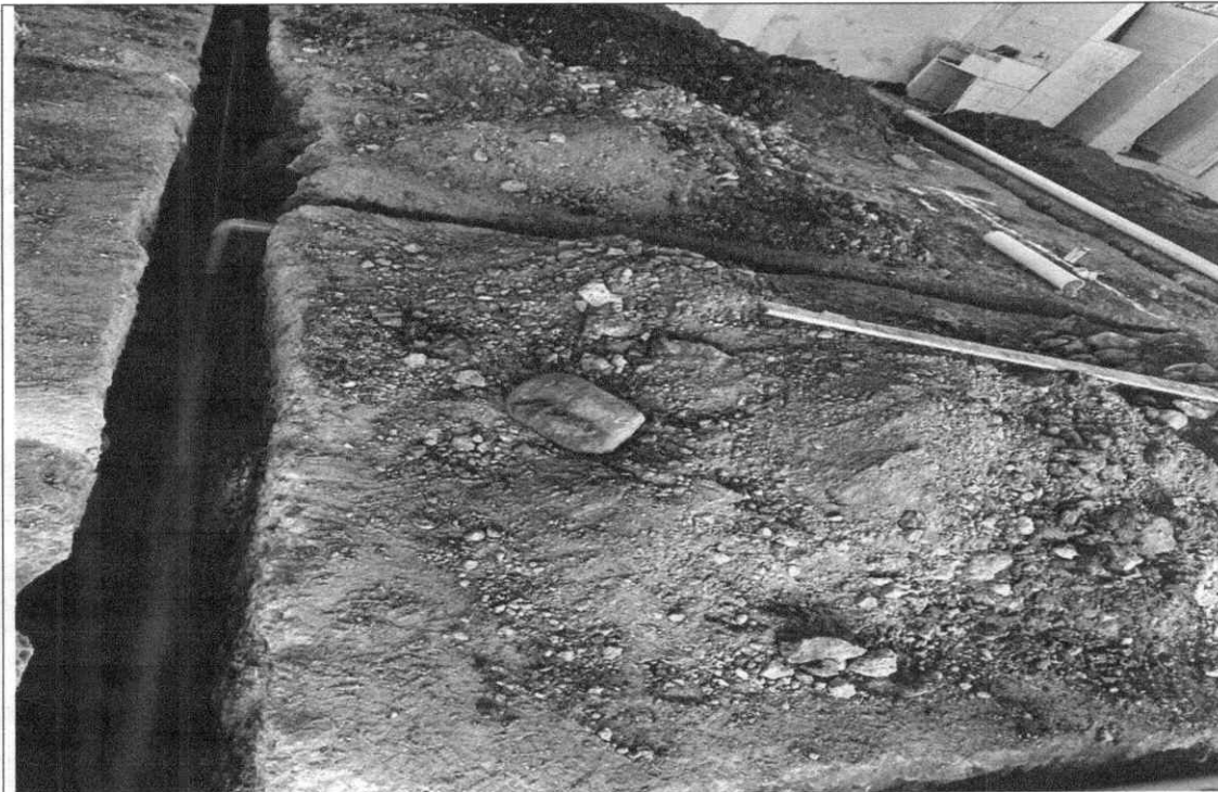
Ilustración 10 suministro e instalación de tubería pvc 4".
