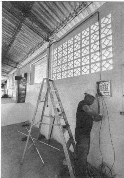
Ilustración 33 Suministro e instalación de tablero trifásico
