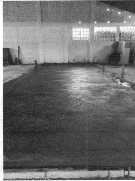
Ilustración 6 Piso en concreto pulido
