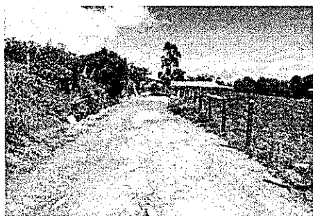
Fotografía 55. Recorrido y verificación final del tramo de empalme San José de la Montaña
