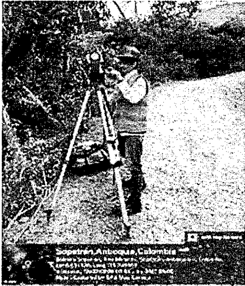
Fotografía 1. Inicio levantamiento topográfico Sopetrán - Horizonte - Belmira
