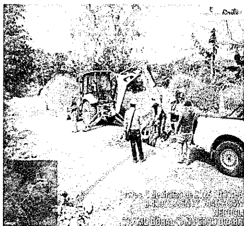
Fotografía 23. Realización de apique San Pedro de Urabá - Necoclí
