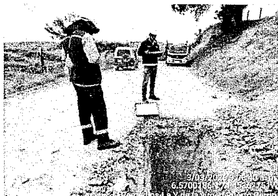
Fotografía 35. Apique Remedios - La Y de la Virgen - Puerto Berrio
