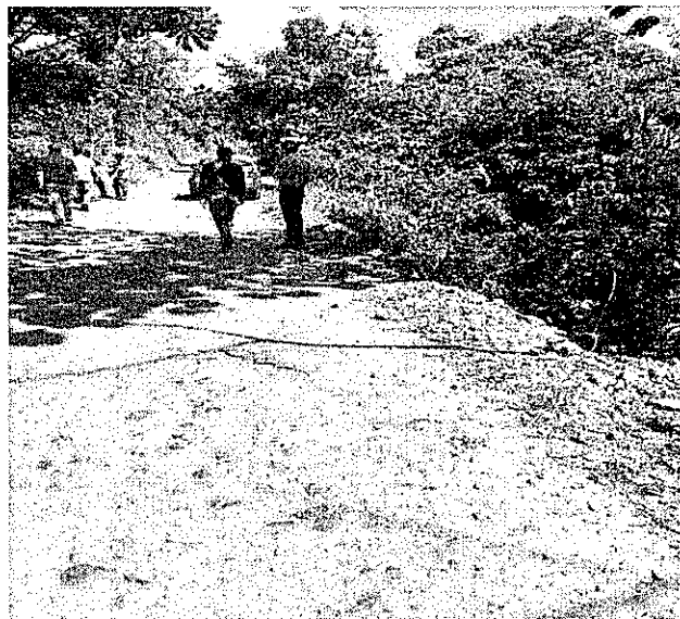
K2 +600 Zona de la vía con ancho reducido.
