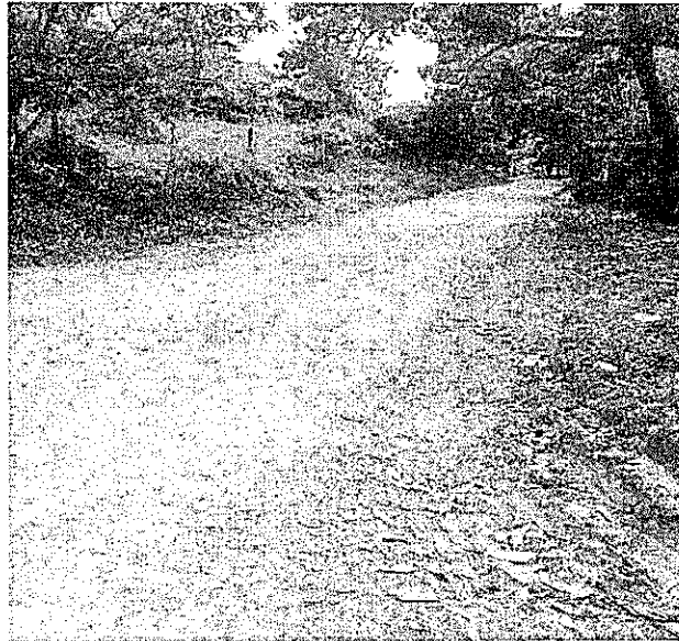
K2 +600 Zona de la vía con ancho reducido.
