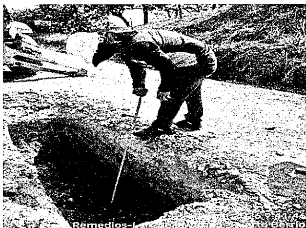
Fotografía 73. Verificación de dimensiones mínimas de apique
