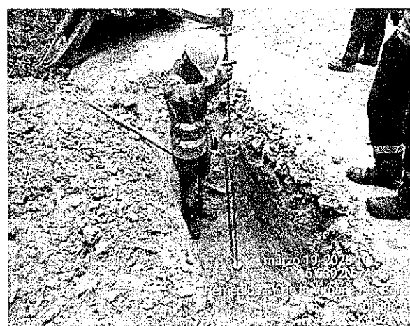
Fotografía 72. Ensayo de laboratorio in situ en apique 25.
