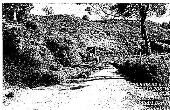
Fotografía 37. Conformación de la vía
