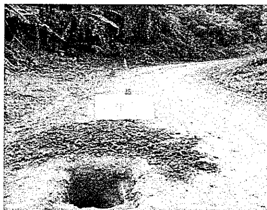
Fotografía 98. Realización apique 50 en el circuito.
