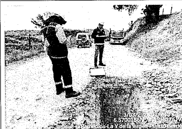
Fotografía 56. Toma de registro en apique realizado.
