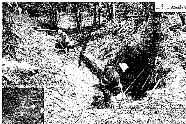
Fotografía 50. Limpieza alcantarilla K2+250
