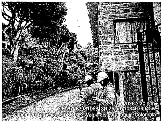
Fotografía 91. Levantamiento topográfico en circuito Valparaíso - Támesis.
