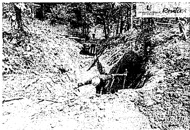
Fotografía 49. Limpieza de obras de drenaje transversal en K2+250
