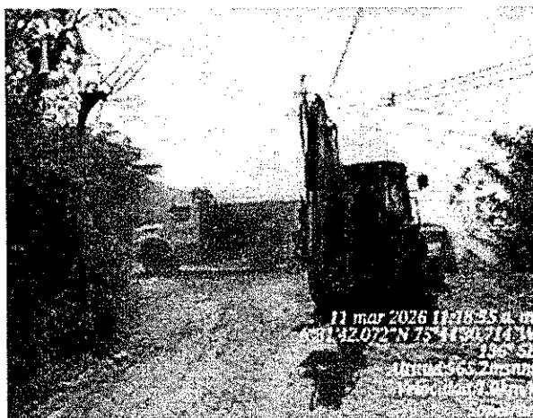
Fotografía 12. Ampliación y conformación del circuito.
