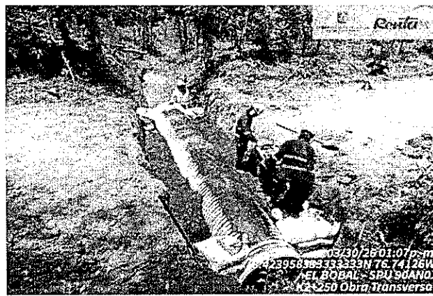
Fotografía 54. Atraque con Sub-Base Granular en K2+250
