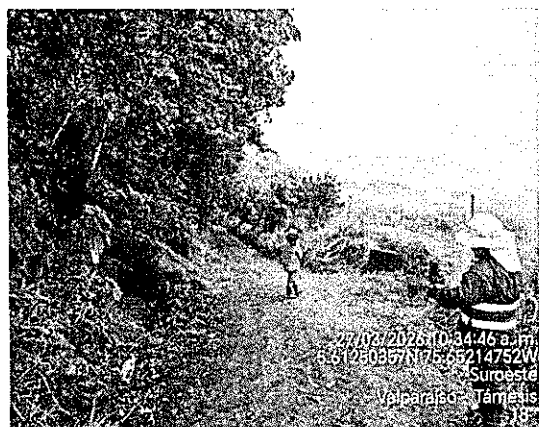
Fotografía 93. Inventario de obras existentes vía Valparaíso - Támesis - Tubería de 18".
