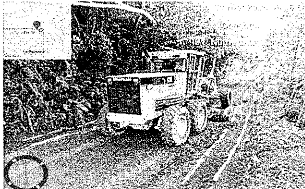
Fotografía 36. Conformación de la vía Frontino - Nutibara
