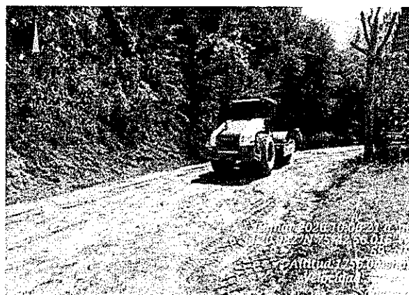
Fotografía 14. Avance en conformación de la vía
