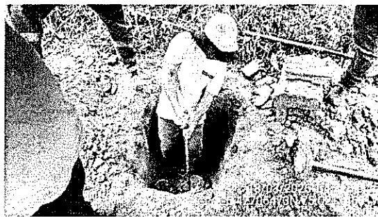
Fotografía 106. Realización de ensayo CBR inalterado K8+000
