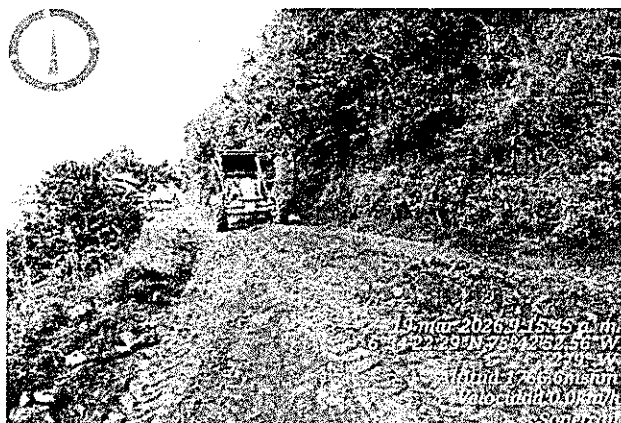
Fotografía 13. Avance en conformación de la vía
