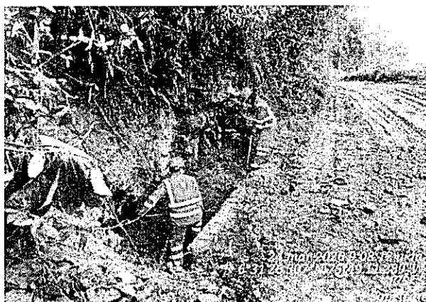
Fotografía 7. Limpieza de obra transversal
