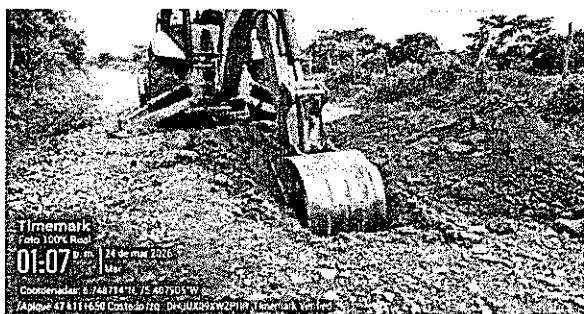
Fotografía 125. Realización de apique 47 - K11+650.
