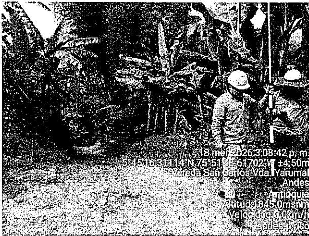
Fotografía 83. Levantamiento topográfico en Andes – San José - Pueblo Rico
