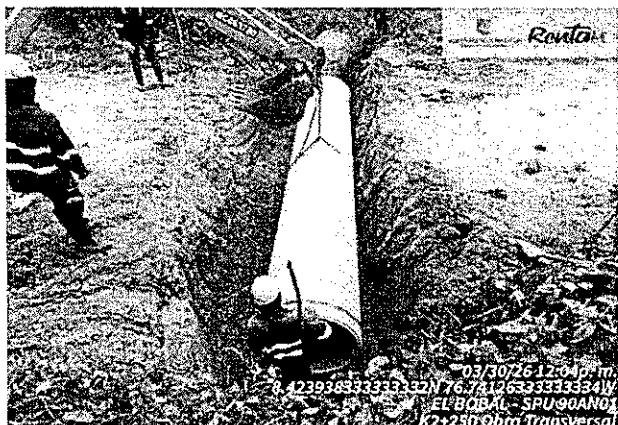
Fotografía 53. Instalación de tubería Novafort de 36" en K2+250
