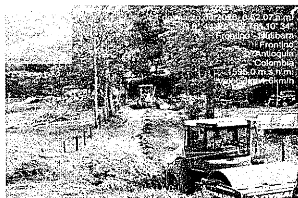
Fotografía 38. Conformación de la vía
