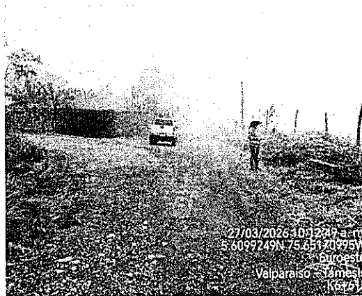
Fotografía 94. Inventario de obras existente vía Valparaíso - Támesis K6+615.
