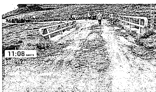
Fotografía 122. Puente en K4+000 con medida preventiva para tránsito.
