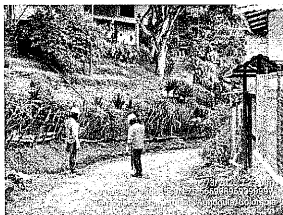
Fotografía 92. Continuación de levantamiento topográfico.
