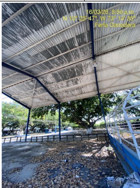
Imagen No. 6. Corrosión en aceros de cubierta. Coliseo Pedro Castro. Zona 2. Fuente: Propia.
