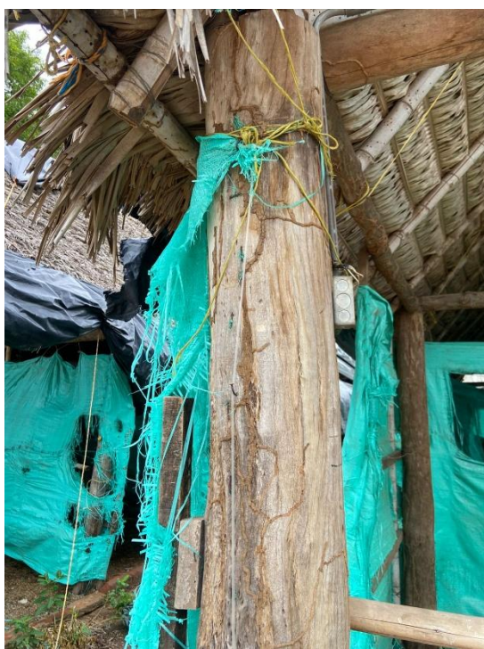
Imagen No. 14. Presencia de xilófagos en estructuras de madera. Zona 4. Fuente: Propia.
