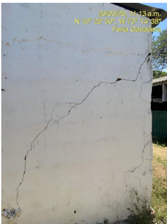
Imagen No. 10. Grieta en diagonal en pesebreras. Zona 3. Fuente: Propia.
