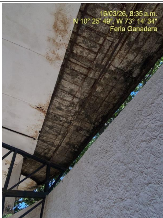
Imagen No. 6. Corrosión en aceros de cubierta. Coliseo Pedro Castro. Zona 2. Fuente: Propia.
