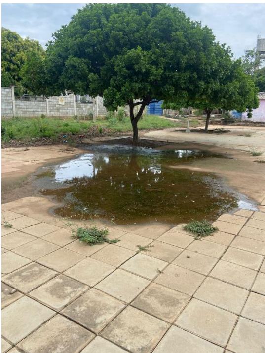
Imagen No. 18. Empozamiento de aguas lluvias en zonas peatonales. Zona 5. Fuente: Propia.
