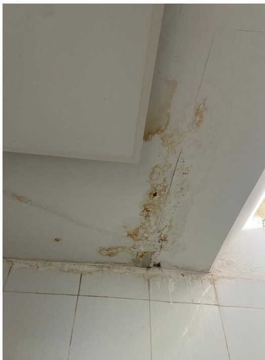
Imagen No. 19. Filtraciones de agua en cielo raso. Zona 5. Fuente: Propia.
