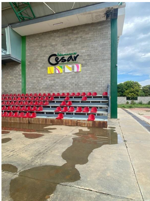
Imagen No. 18. Empozamiento de aguas lluvias en zonas peatonales. Zona 5. Fuente: Propia.
