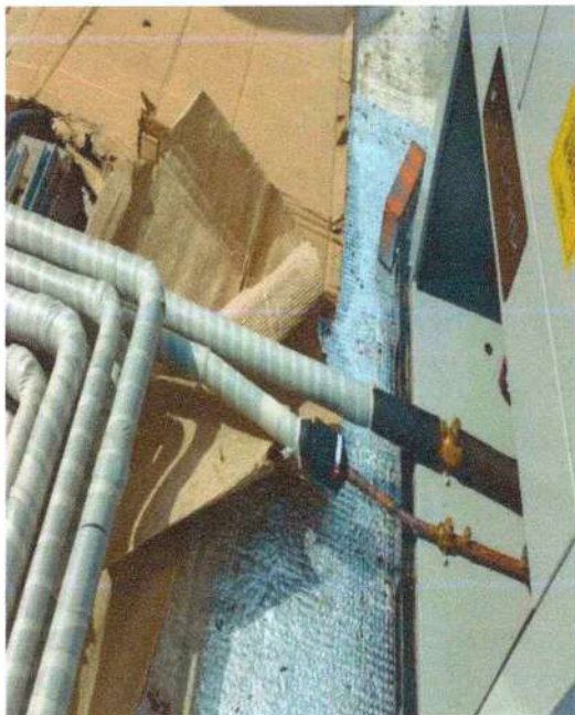
Figura 25- Página 48-50 Verificación técnica del funcionamiento del sistema.
