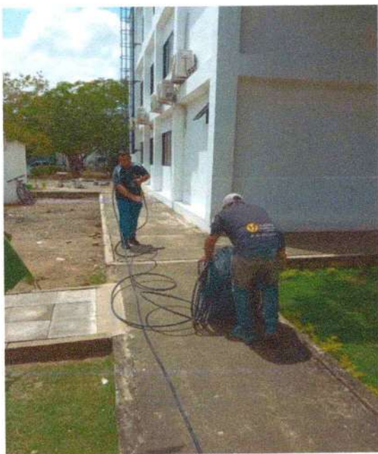
Figura 4- Página 10- Instalación inicial de tuberías y canalizaciones exteriores.
