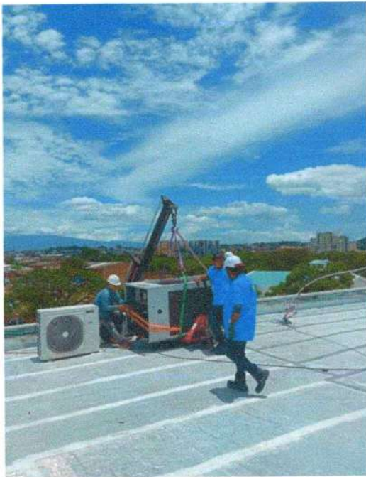
Figura 9- Página 16- Izaje de las unidades condensadoras.
