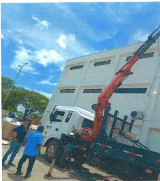
Figura 7- Página 14- Maniobras para el suministro e ingreso de los equipos principales.
