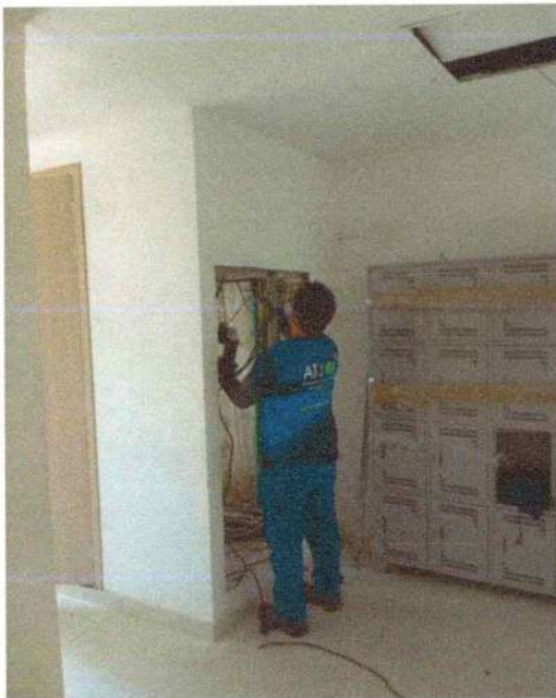
Figura 19- Página 22- Intervención sobre gabinete eléctrico.
