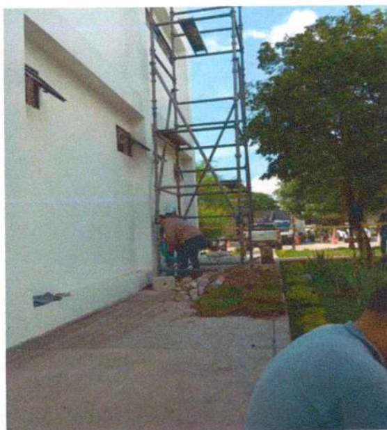
Figura 2- Página 5- Excavación y adecuaciones preliminares para la instalación de la nueva infraestructura.
