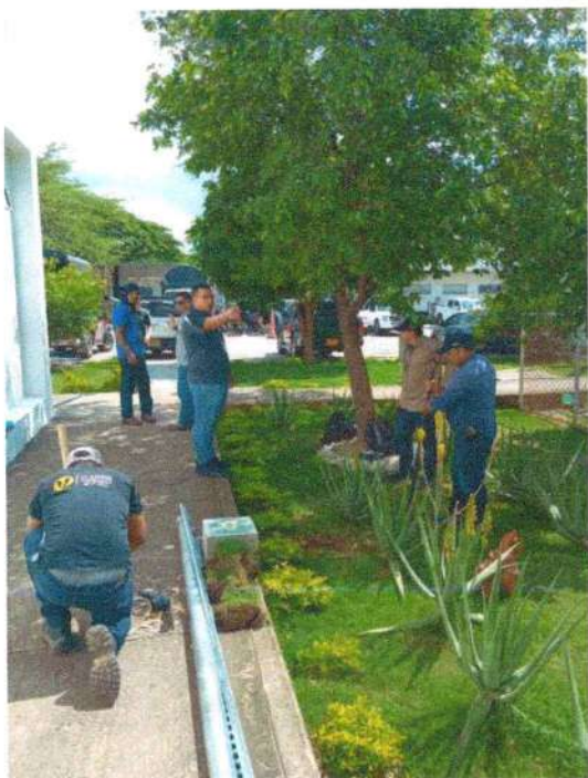
Figura 1- Página 1- Inicio de la intervención y adecuación del área de trabajo
