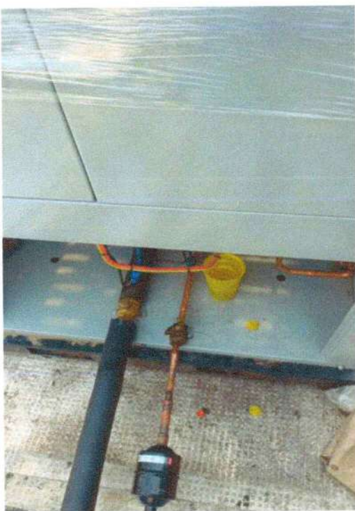
Figura 16- Página 40-Sistema instalado durante la fase final de montaje.
