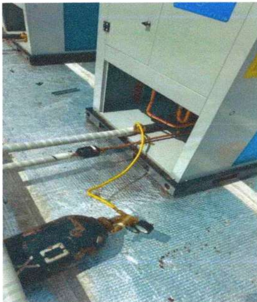
Figura 22- Página 31- Verificación de conexiones y pruebas de funcionamiento.
