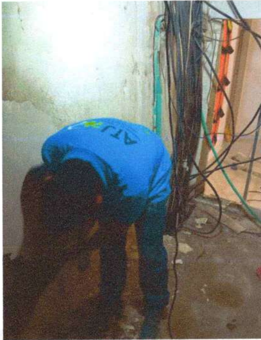
Figura 18- Página 15- Adecuaciones eléctricas interiores.
