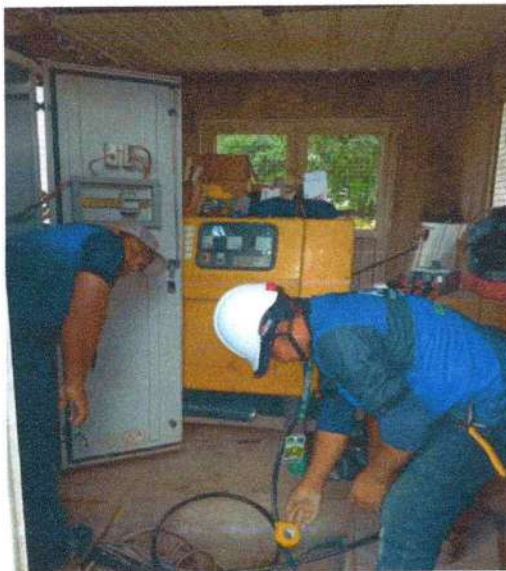
Figura 17- Página 11- Adecuación del punto principal de alimentación eléctrica.
