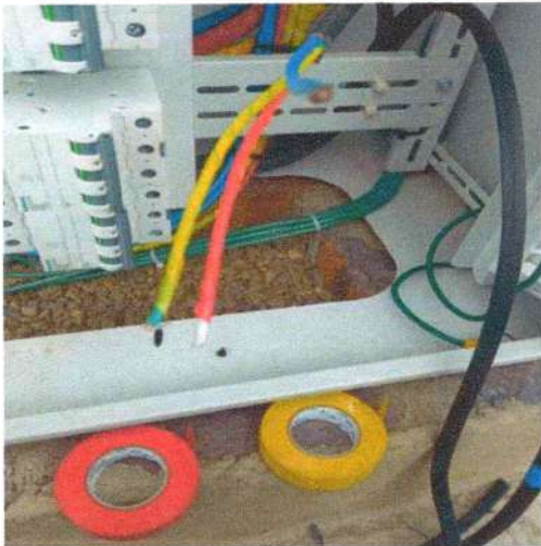
Figura 20- Página 29- Sistema de protecciones y conexiones eléctricas.
