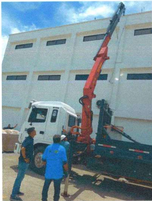
Figura 6- Página 12- Llegada de los equipos mediante camión grúa.
