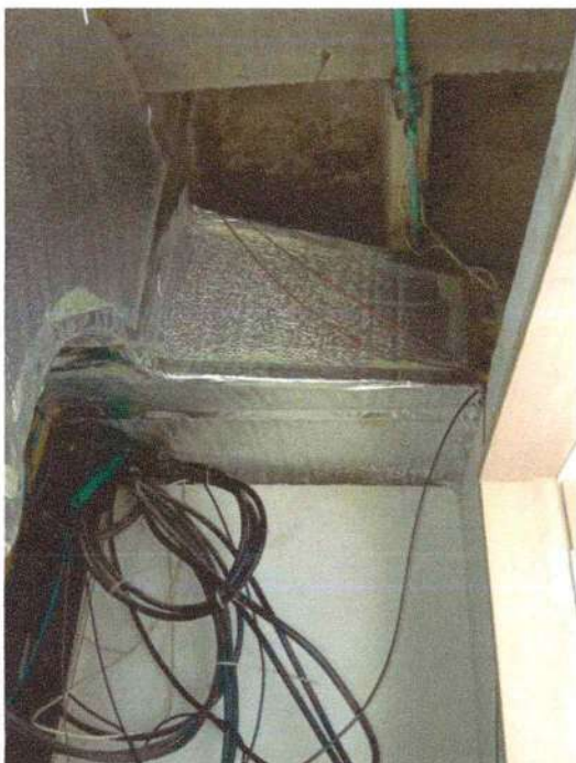
Figura 27- Página 48-50 Verificación técnica del funcionamiento del sistema.
