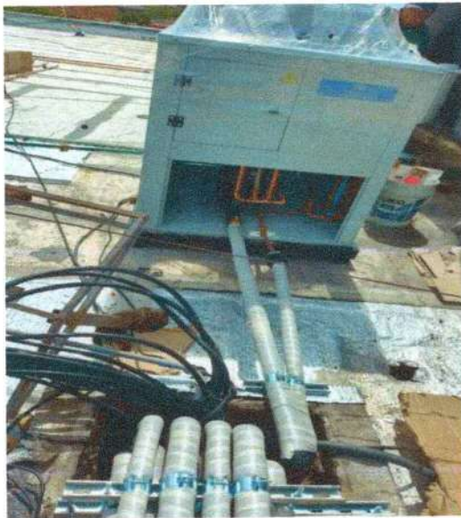
Figura 14- Página 33-35 Integración de ductería y conexiones.
