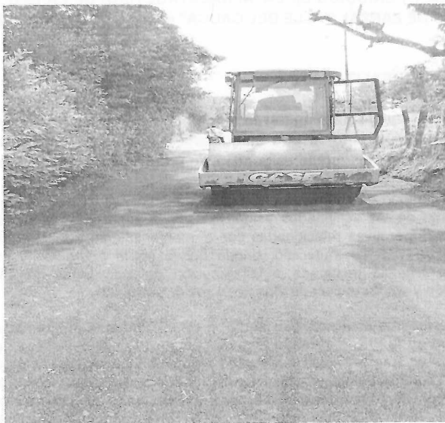
Registro fotográfico de las actividades desarrolladas con maquinaria amarilla, orientadas a la distribución, nivelación y conformación del material fresado utilizado para el mejoramiento de la superficie vial, en cumplimiento de las instrucciones impartidas por la supervisión.
