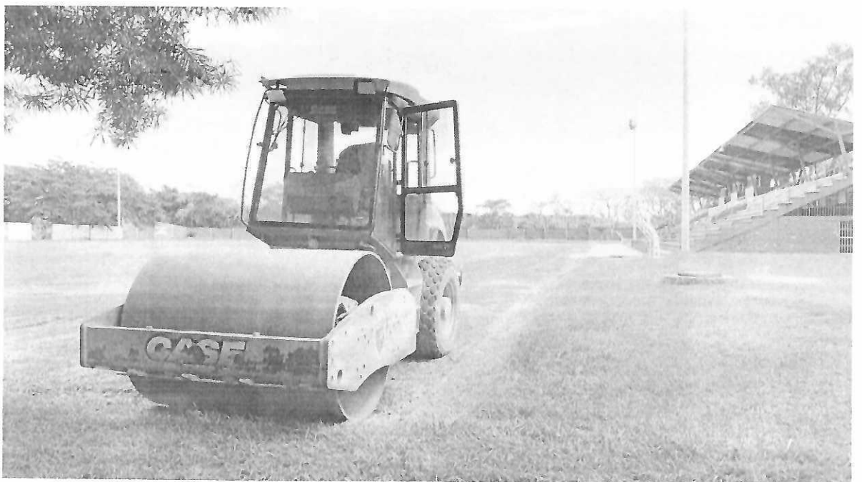
Evidencia de las actividades operativas realizadas para la disposición, extendido y organización del material fresado sobre el área intervenida, buscando mejorar las condiciones de uniformidad y estabilidad de la superficie utilizada por la comunidad.
