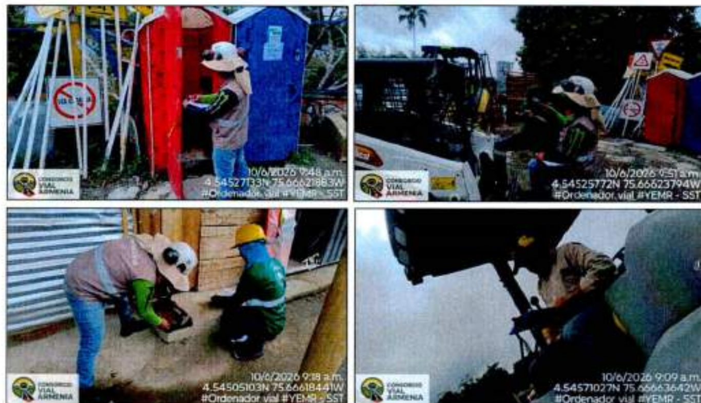
Imagen 11 evidencia fotográfica de inspecciones
