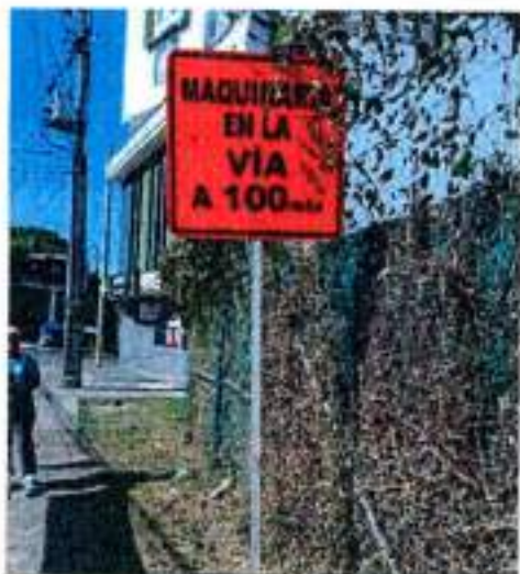
Maquinaria en la vía a 100m
