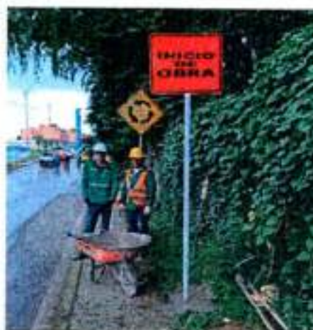
Inicio de obra
