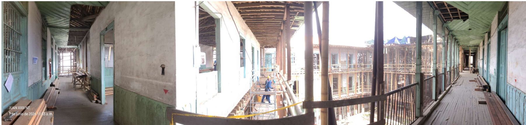
3 - Pasillo interior, costado norte - Patio central, Piso 2 - eje 7 y eje E
