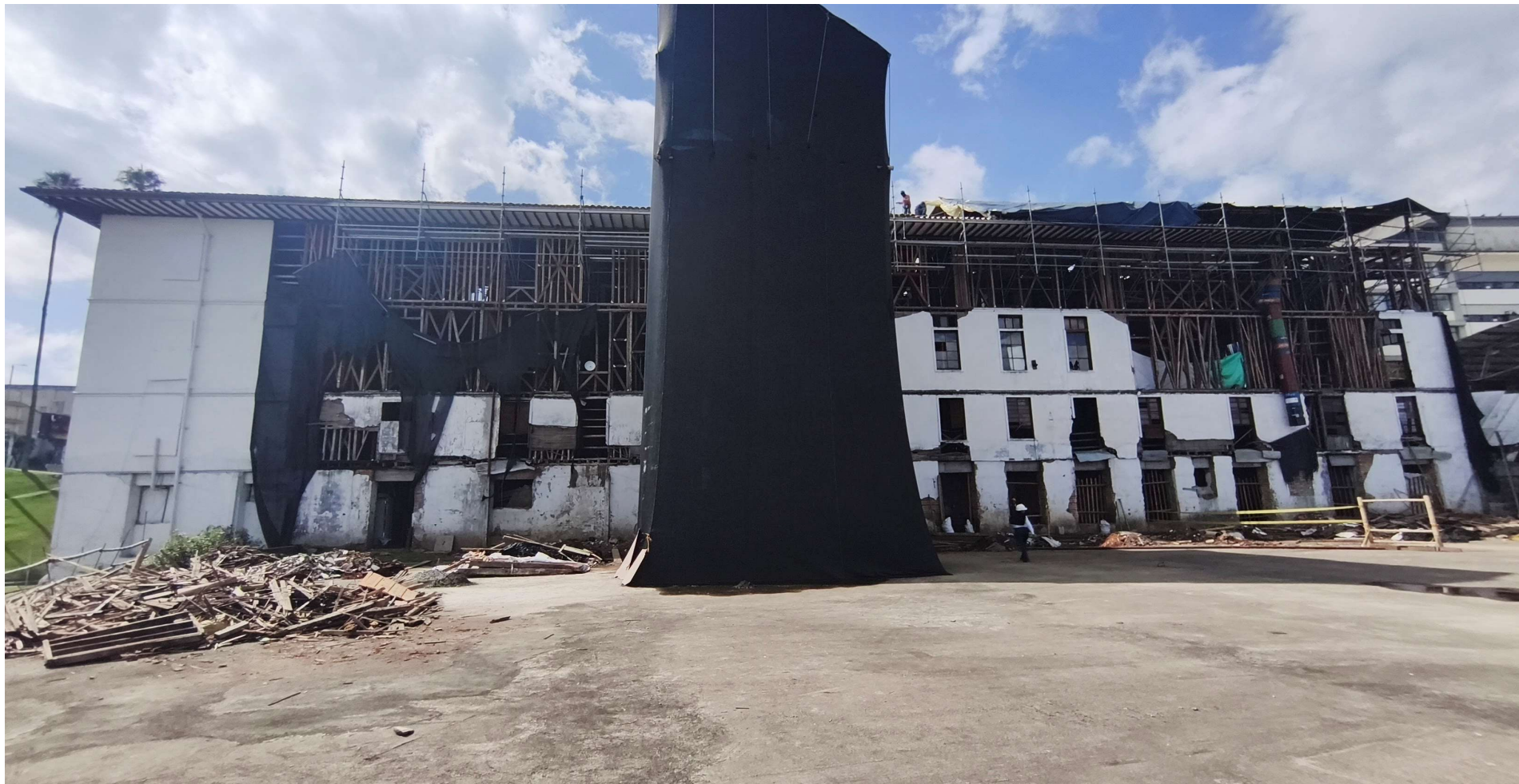
F - Fachada Sur Edificio de Restauración
