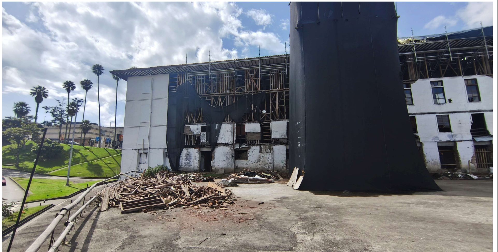
F - Esquina suroccidental - Fachada Sur Edificio de Restauración
