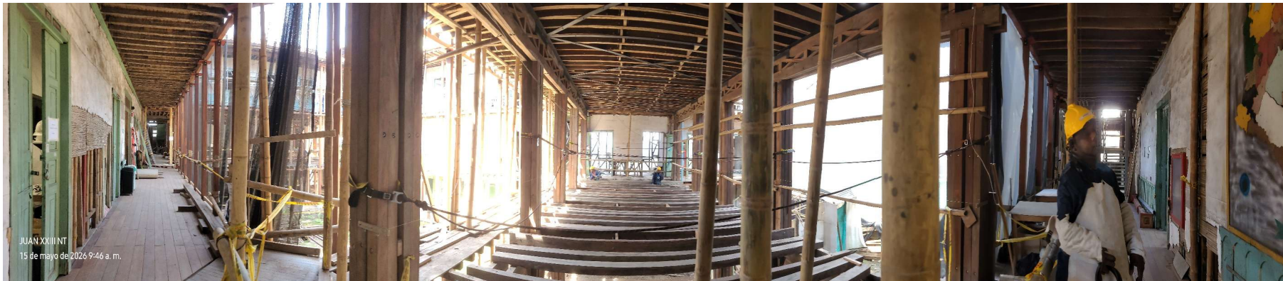
4 - Pasillo interior, costado norte - Patio central, Piso 1 - eje 4 y eje E
