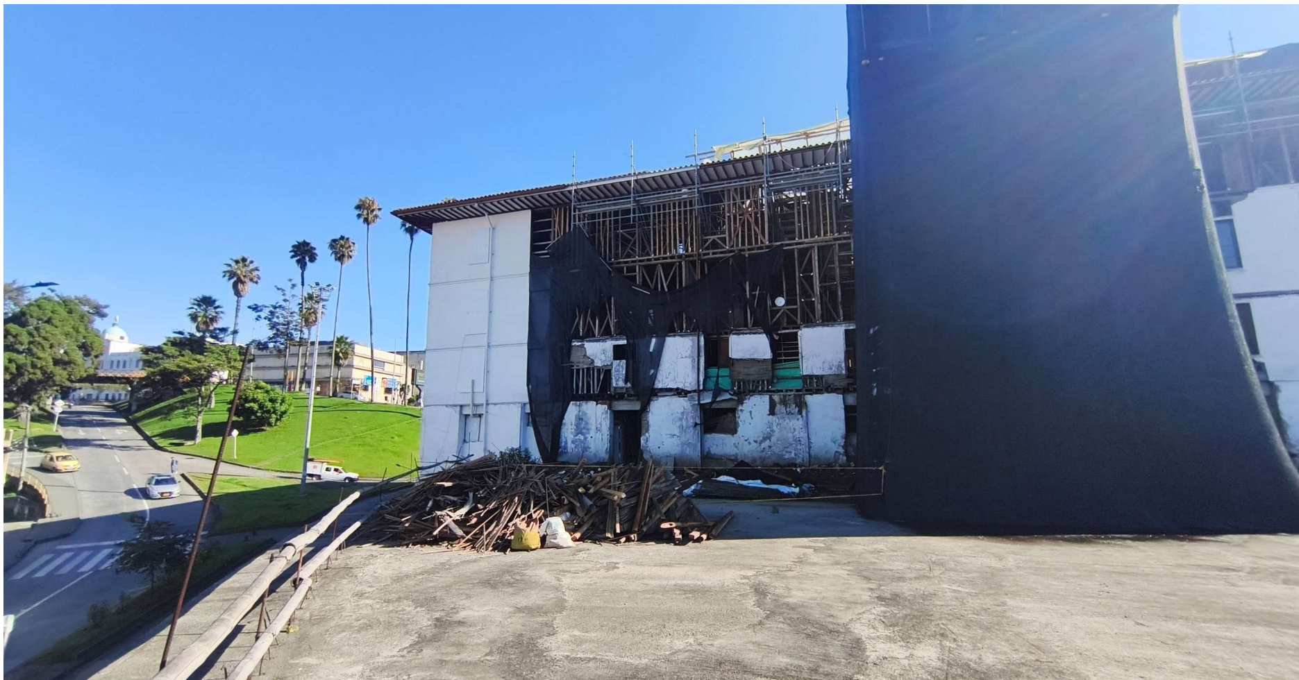
F - Esquina suroccidental - Fachada Sur Edificio de Restauración
