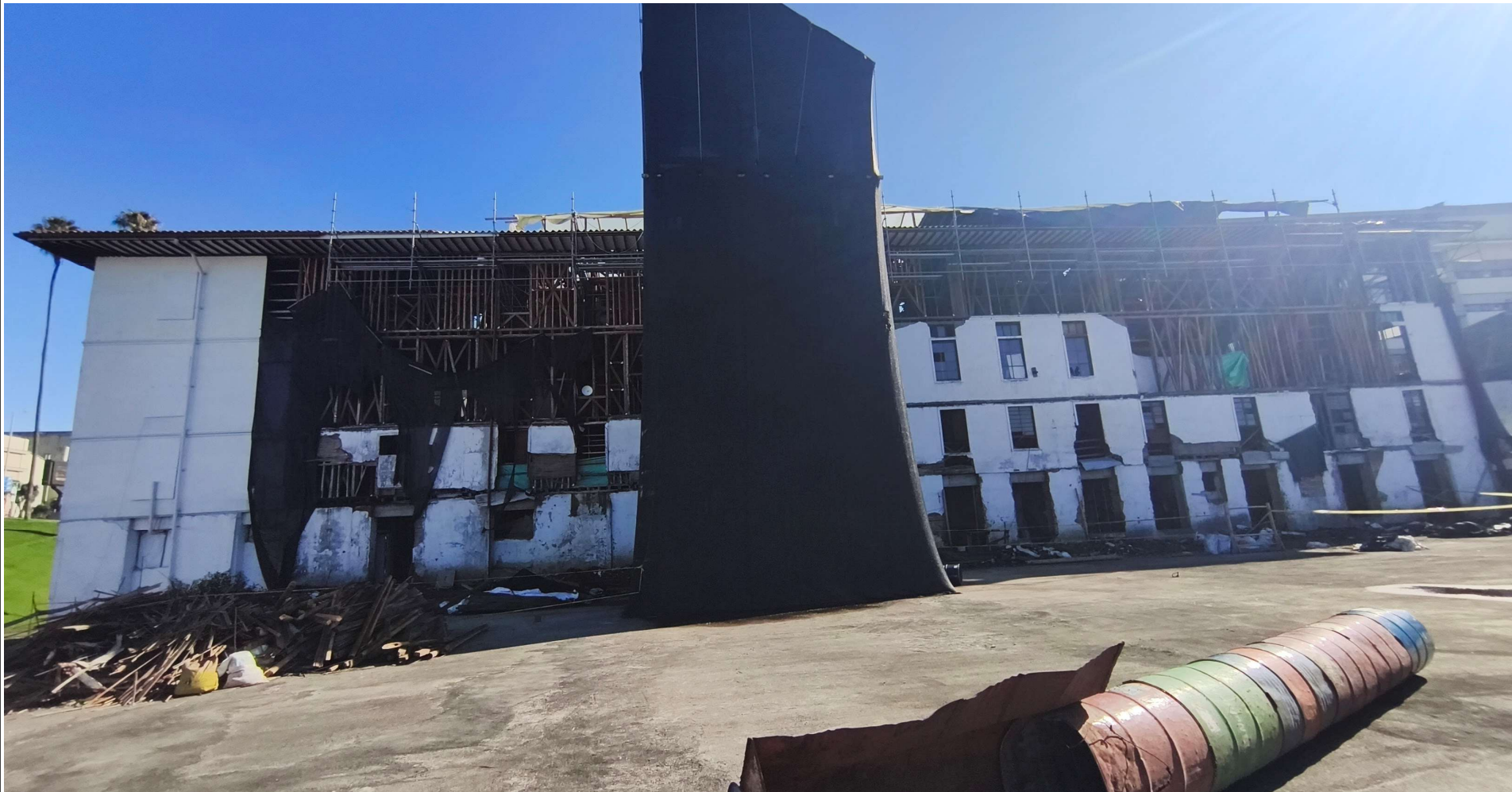
F - Fachada Sur Edificio de Restauración
