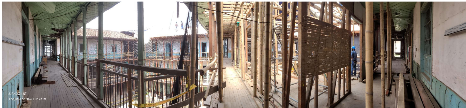
4 - Pasillo interior, costado norte Patio central, Piso 2 - eje 4 y eje E
