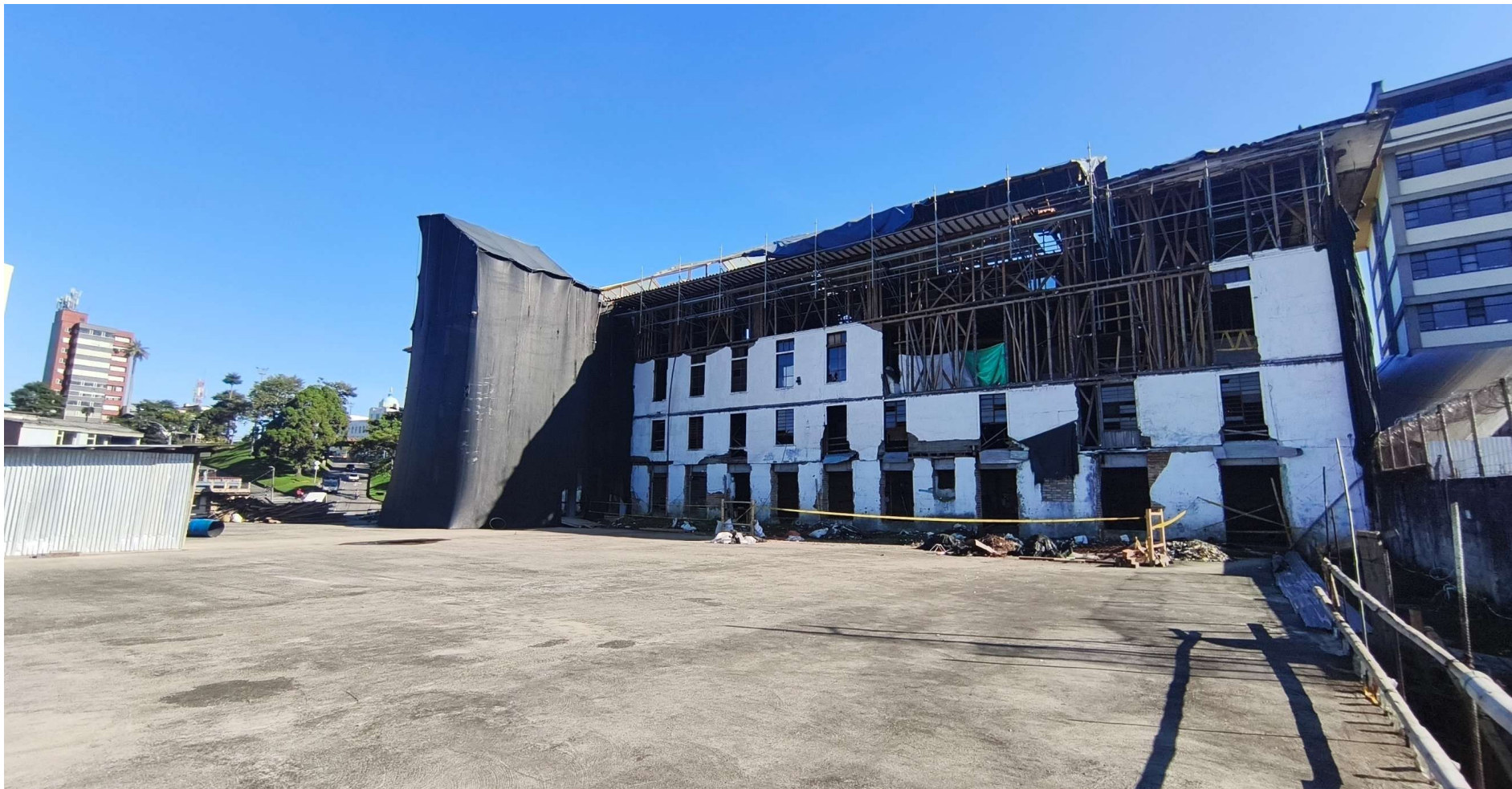
D - Esquina suroriental Fachada sur Edificio de Restauración
