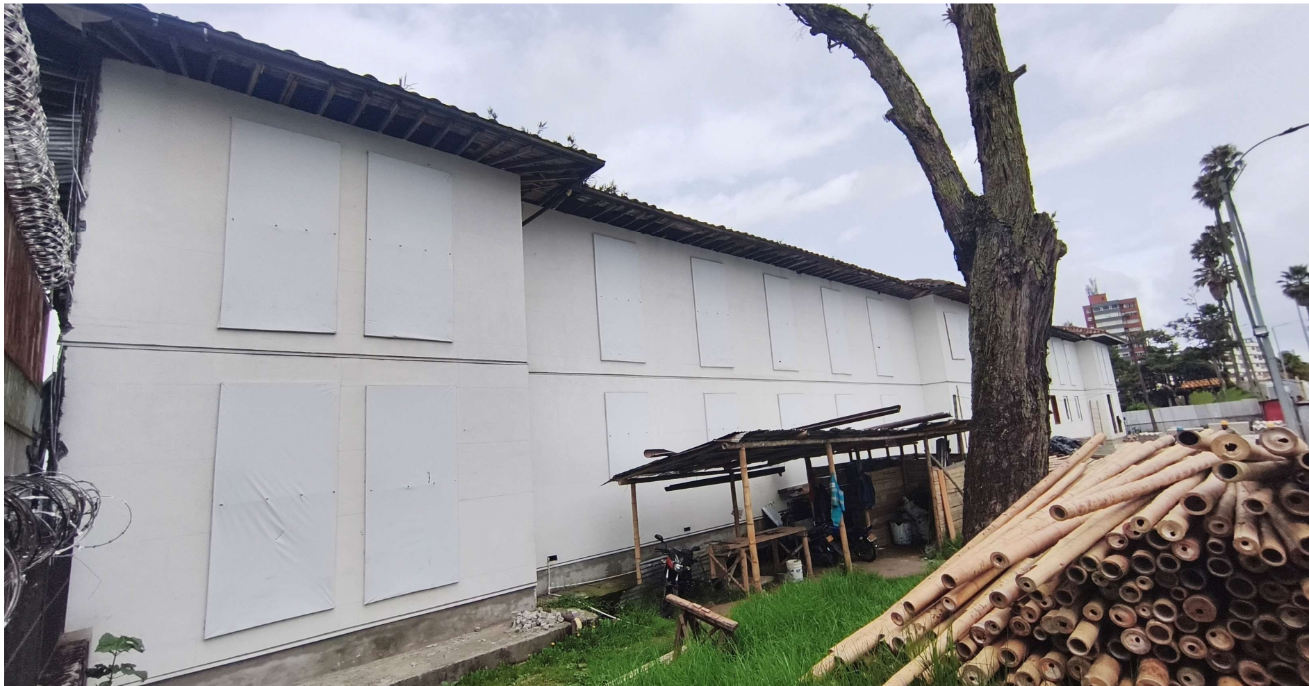
D - Esquina nororiental (Av. Santander) Edificio de Restauración - Fachada norte
