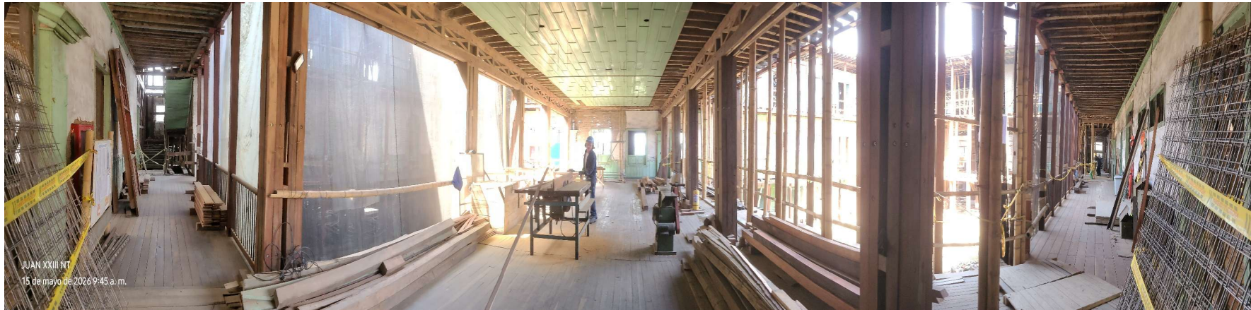
3 - Pasillo interior, costado norte - Patio central, Piso 1 - eje 7 y eje E
