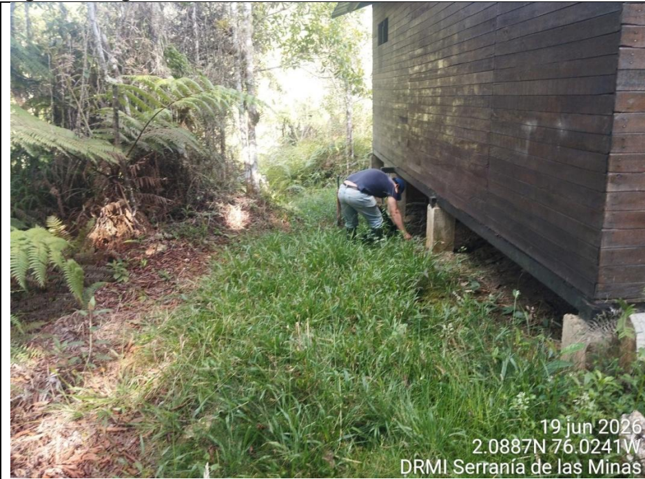
Mantenimiento Cabaña El Roble
