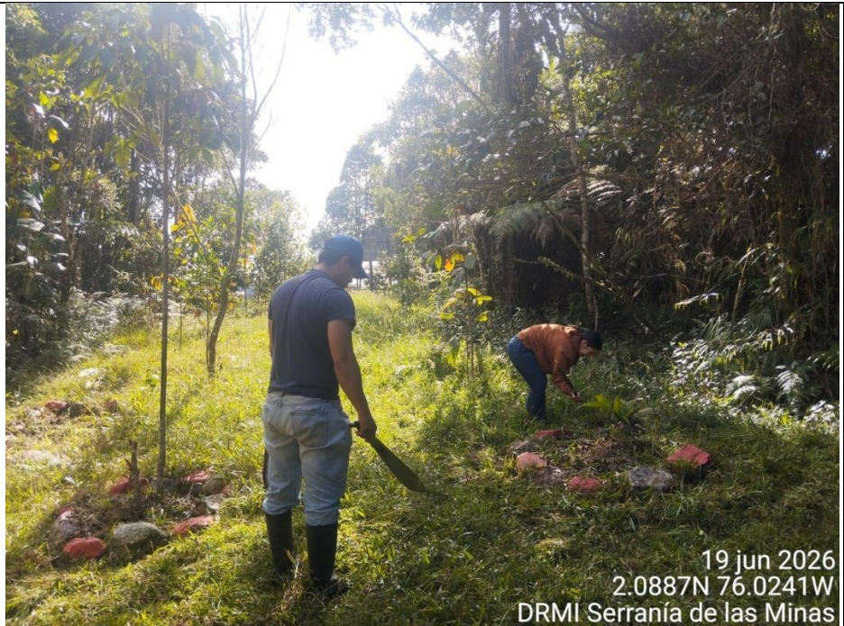
Mantenimiento Cabaña El Roble
