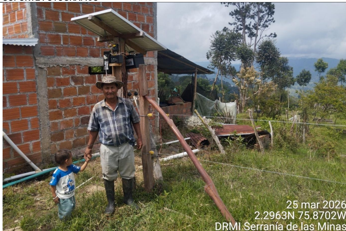
Visita de Seguimiento a proyecto de ganadería sostenible con cerca eléctrica de panel solar, La Florida, El Pital
