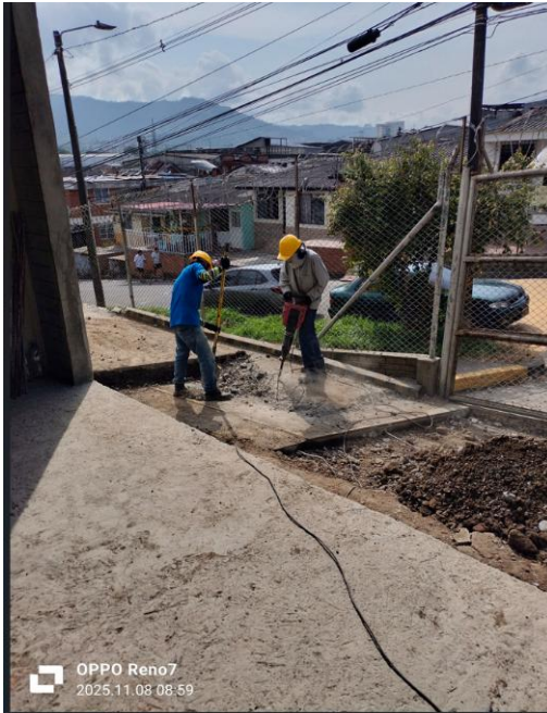
DEMOLICION MECANICA DE CONCRETOS
