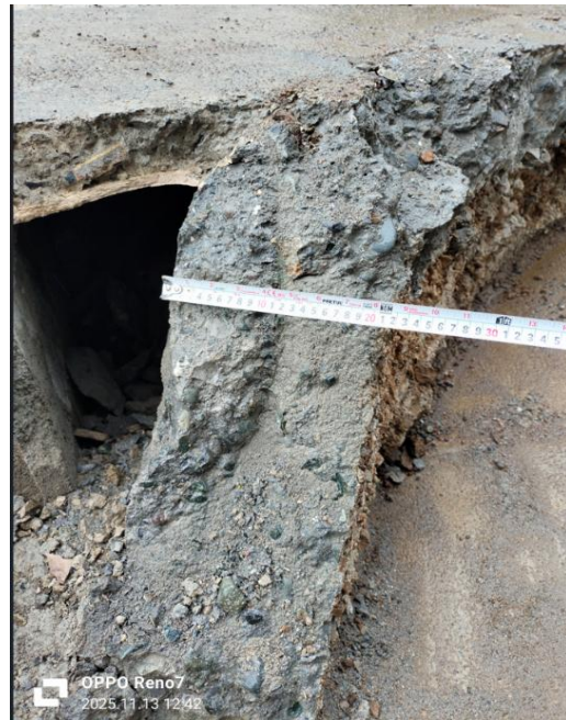
DEMOLICION MECANICA DE CONCRETOS
