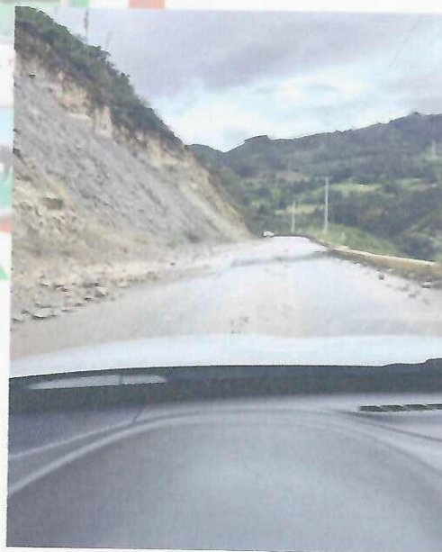
Descripción: Foto Recolección de material vía principal.
