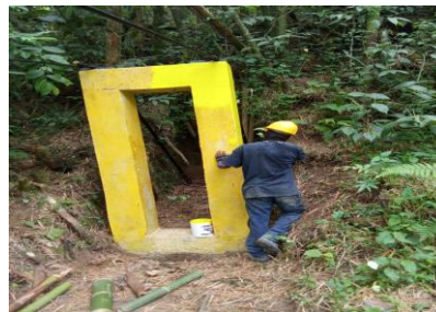
Fotografías 20-21. Restauración pintura resistente al agua. Fuente: Contratista.
