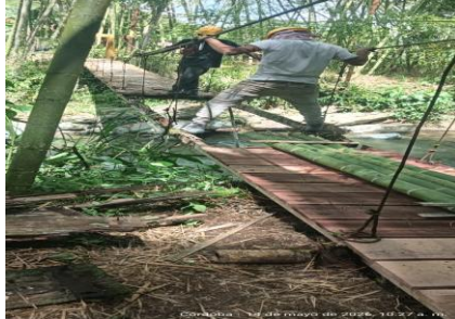
Fotografías 1-2. Estado inicial: tablero de piso deteriorado y cables principales. Fuente: Contratista.
