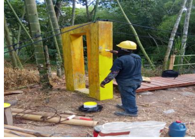
Fotografías 12-13. Restauración pintura resistente al agua. Fuente: Contratista.
