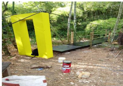
Fotografías 38-39. Estado final del sistema de barandas. Fuente: Contratista.
