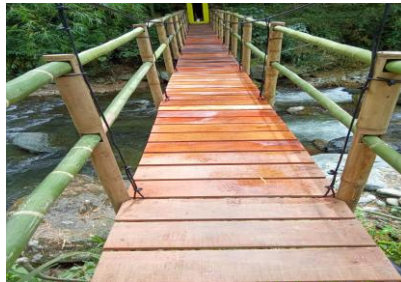
Fotografías 28-29. Acabados finales en tablero y barandas. Fuente: Contratista.
