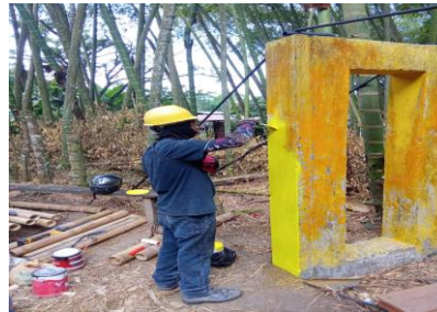
Fotografías 16-17. Restauración pintura resistente al agua. Fuente: Contratista.
