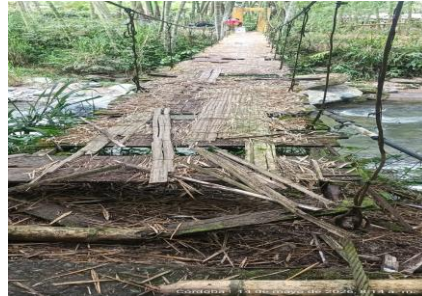
Fotografías 3-4. Deterioro de tabloncillos y elementos de guadua. Fuente: Contratista.
