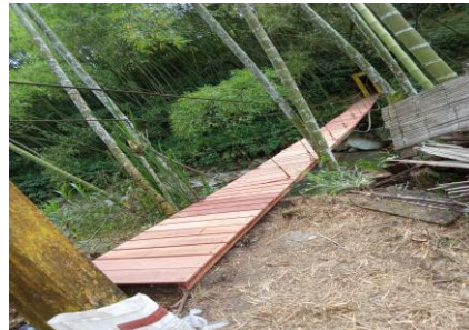
Fotografías 6-7. Desmonte de estructura de piso y tirantes laterales. Fuente: Contratista.
