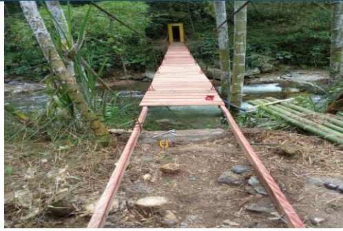
Fotografía 8. Retiro de madera deteriorada y limpieza de la estructura. Fuente: Contratista.
