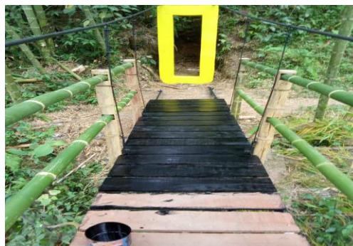
Fotografía 40. Pintura protección frente al agua Fuente: Contratista.
