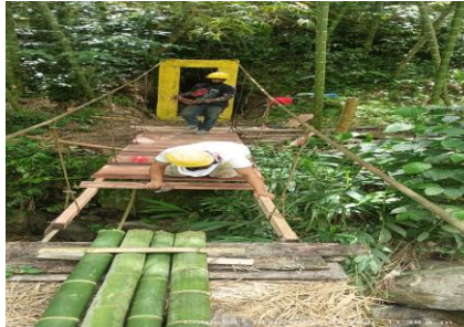
Fotografías 3-4. Deterioro de tabloncillos y elementos de guadua. Fuente: Contratista.
