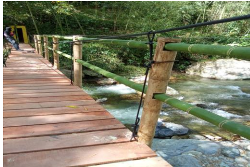
Fotografía 11. Avance del tablero de piso instalado. Fuente: Contratista.
