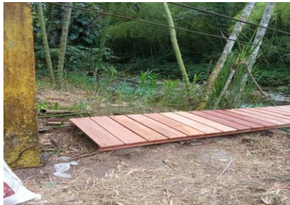
Fotografías 6-7. Desmonte de estructura de piso y tirantes laterales. Fuente: Contratista.
