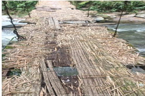
Fotografía 5. Vista general del puente antes de la intervención. Fuente: Contratista.
