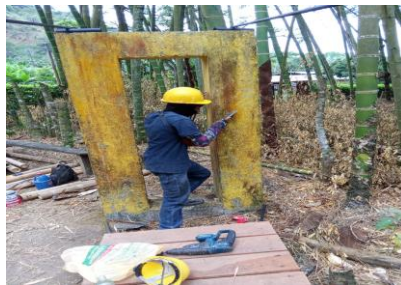
Fotografías 20-21. Restauración pintura resistente al agua. Fuente: Contratista.
