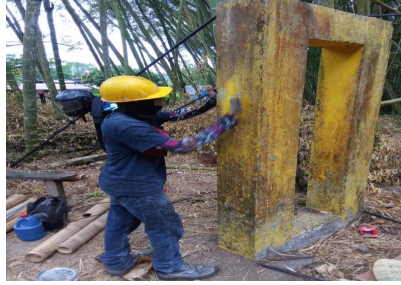
Fotografías 12-13. Restauración pintura resistente al agua. Fuente: Contratista.
