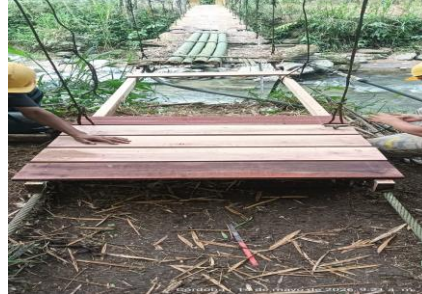
Fotografías 1-2. Estado inicial: tablero de piso deteriorado y cables principales. Fuente: Contratista.
