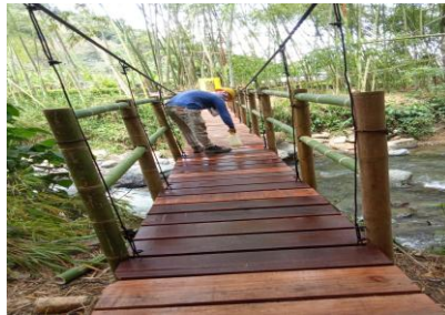
Fotografías 26-27. Inmunización tablero chanul. Fuente: Contratista.
