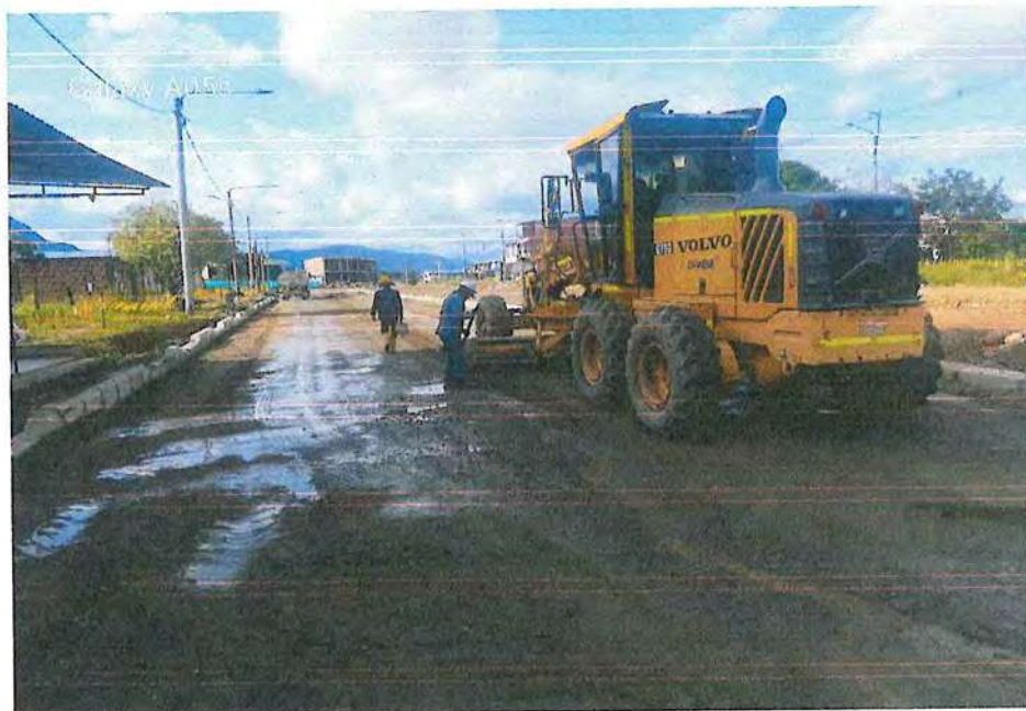
Ilustración 3 Motoniveladora de 148 Hp en obra
