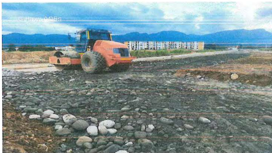
Ilustración 4 Vibro compactador Auto pulsado de 10 ton en obra
