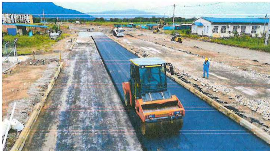
Ilustración 10 Compactador doble rodillo.
