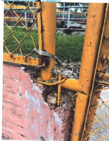
Ilustración 16. Estructura de soporte en mal estado y Columnetas de confinamiento con exposición de aceros
