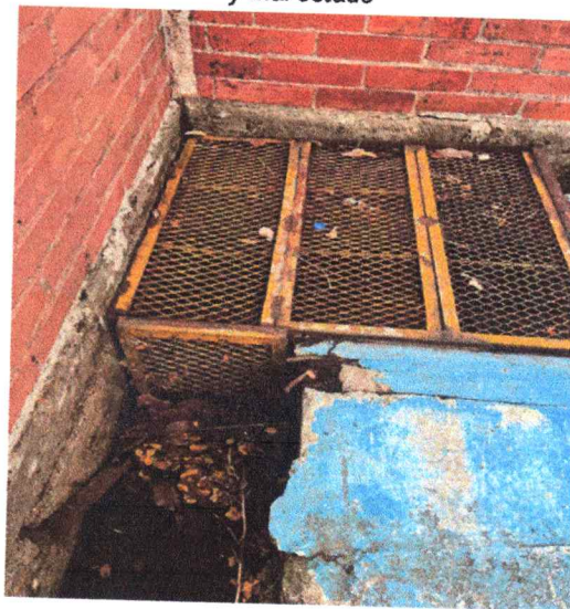
Ilustración 20. Mejoramiento de cuneta para el manejo de aguas lluvias
