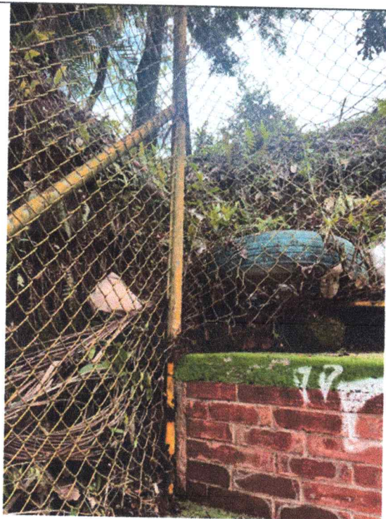
Ilustración 21. Mejoramiento del talud y construcción de trinchos en guadua
