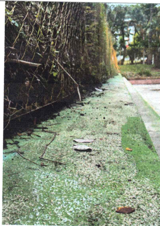
Ilustración 22. Mejoramiento del talud y construcción de trinchos en guadua
