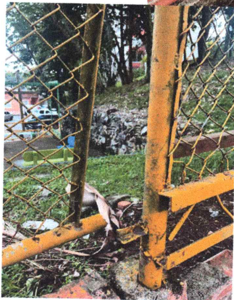
Ilustración 15. Malla de cerramiento oxidada, en mal estado y deterioro de pintura
