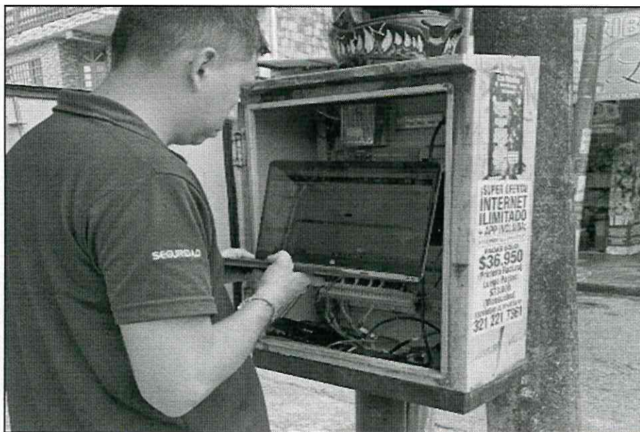
Imagen 28: Registro fotografico del mantenimiento preventivo barrio la Macarena: Del 23 al 29 de marzo del 2026
