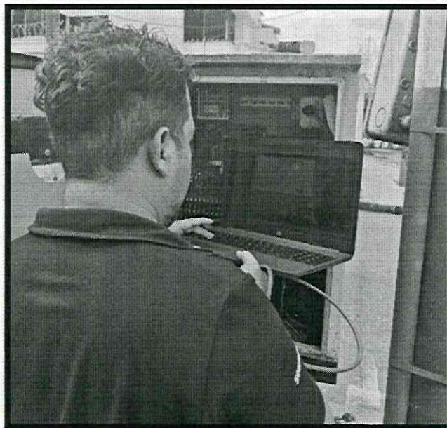
Imagen 16: Registro fotografico del mantenimiento preventivo Barzal alto templete Del 16 al 22 de marzo de marzo de 2026
