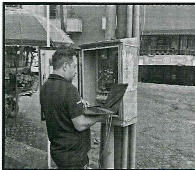
Imagen 13: Registro fotografico del mantenimiento preventivo Bomba la paz Del 9 al 15 de marzo de marzo de 2026
