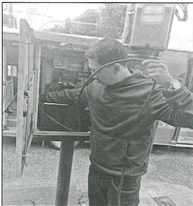
Imagen 58: Registro fotografico del mantenimiento correctivo interseccion semaforica barrio San Carlos: 31 de marzo 2026
