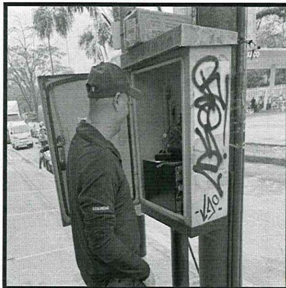
Imagen 40 : Registro fotografico del mantenimiento correctivo remanso Carrera 16 X Calle 15: Del 9 al 13 de marzo de marzo de 2026
