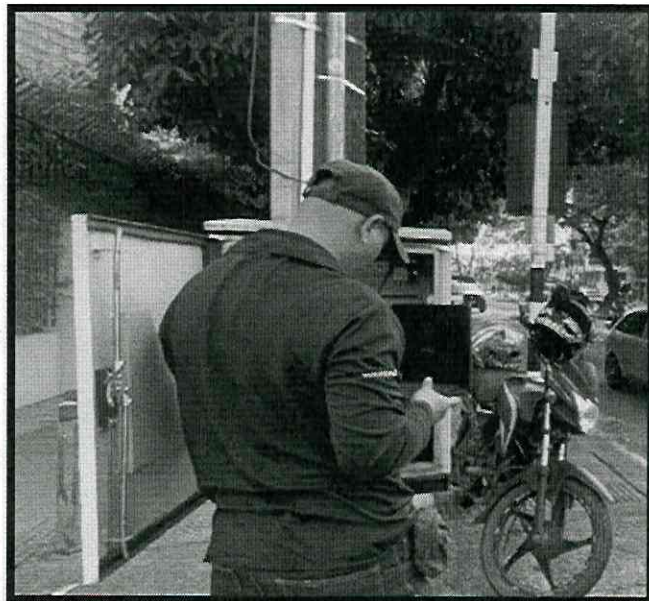
Imagen 08 : Registro fotografico del mantenimiento preventivo cantarrana Del 9 al 15 de marzo de marzo de 2026
