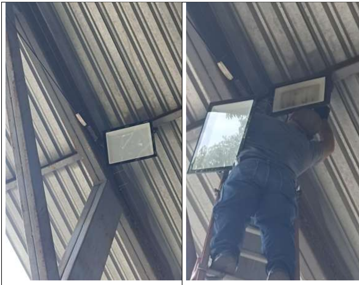
Reemplazo e instalación de reflectores
