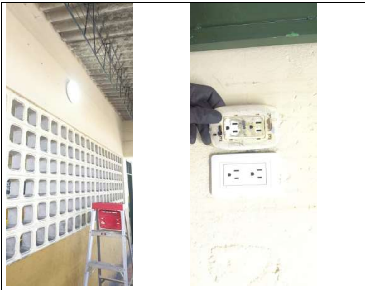
Reemplazo de lámparas y tomacorrientes doble
