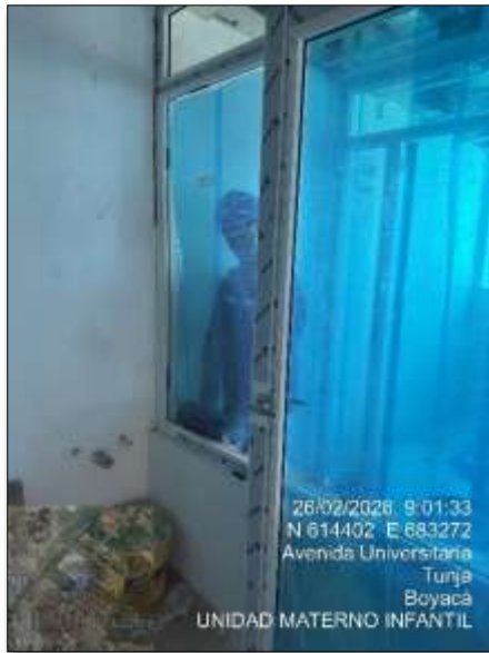
Imagen 43: Instalación de ventanería Nivel 2
