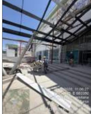
Imagen 26. Pergola fachada occidental
