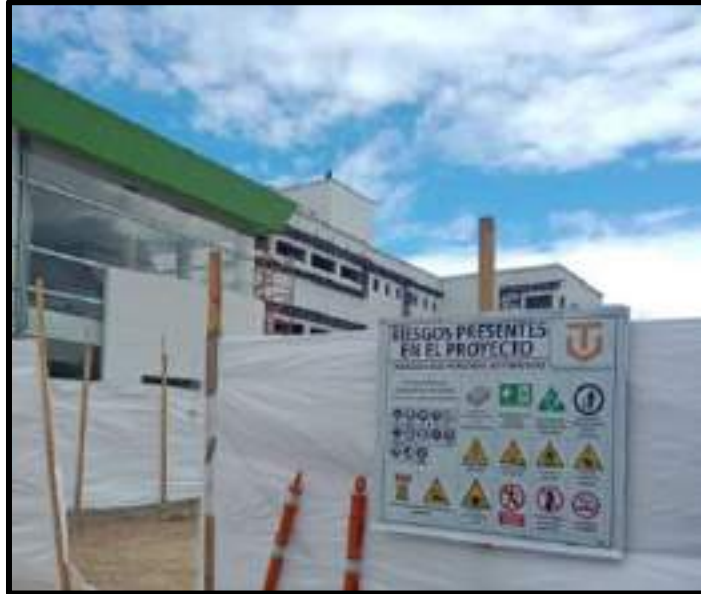
Ilustración 23. Señalización de prevención en obra
