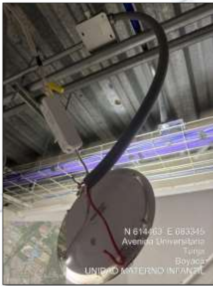
Imagen 45: Instalación de cable FPLP
