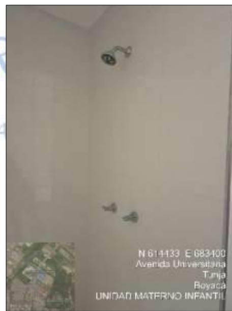
Imagen 58: Instalación de duchas y mezclador
