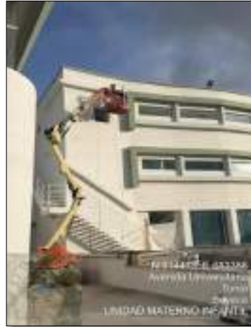
Imagen 39. Hounter Douglas fachada occidental
