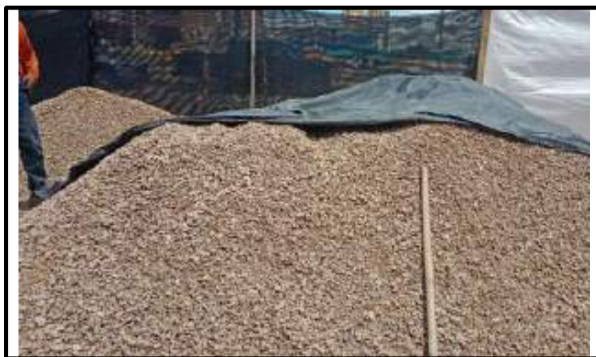
Ilustración 14. Acopio de gravilla
