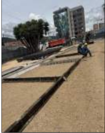
Imagen 37. Relleno con base granular
