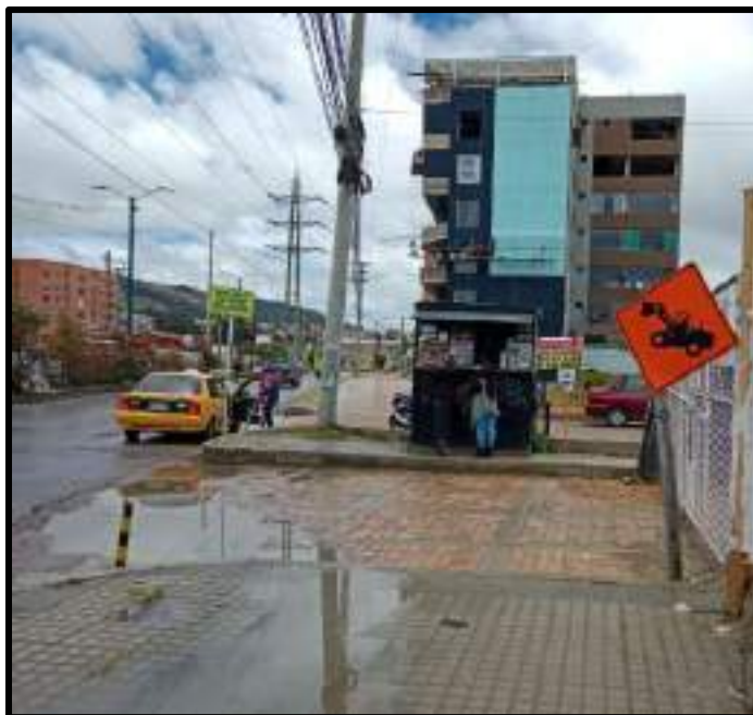
Ilustración 25. señalización entrada y salida de volquetas y maquinaria (manejo de tránsito)
