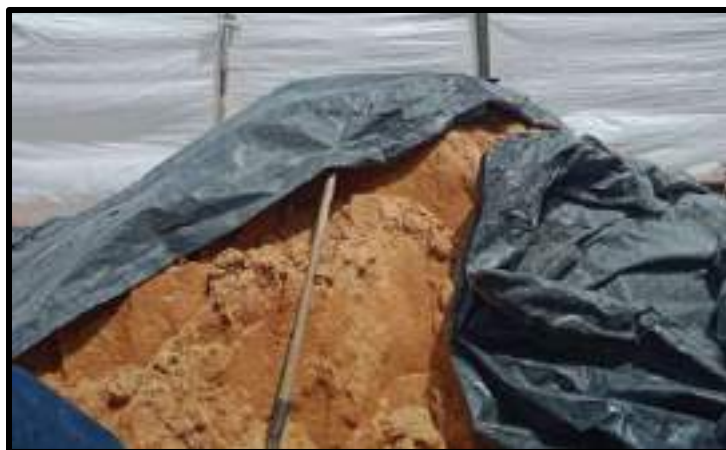
Ilustración 13. Acopio de arena
