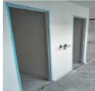
Fotografía 9 y 10. Instalación de puertas de aluminio.
