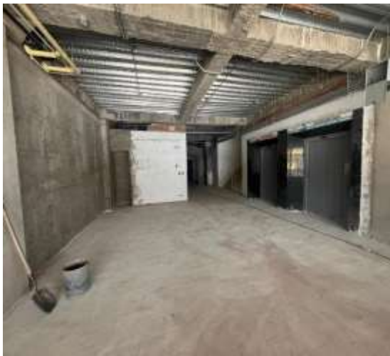
Imagen 25: Sala de espera
