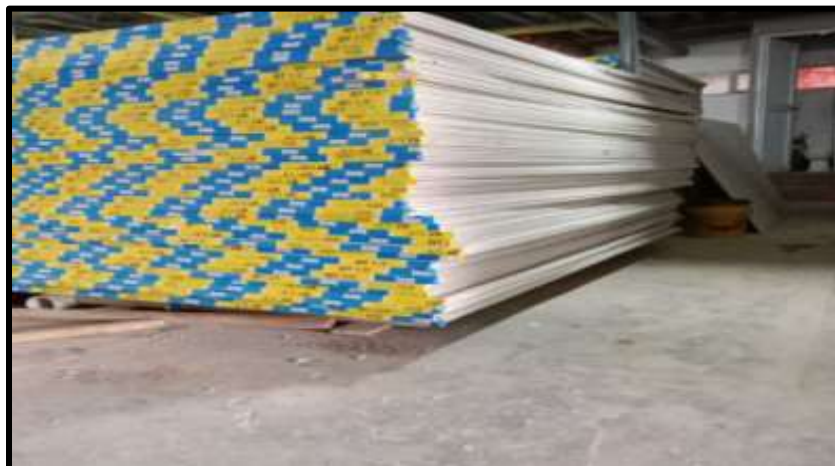
Ilustración 19. Acopio de superboard
