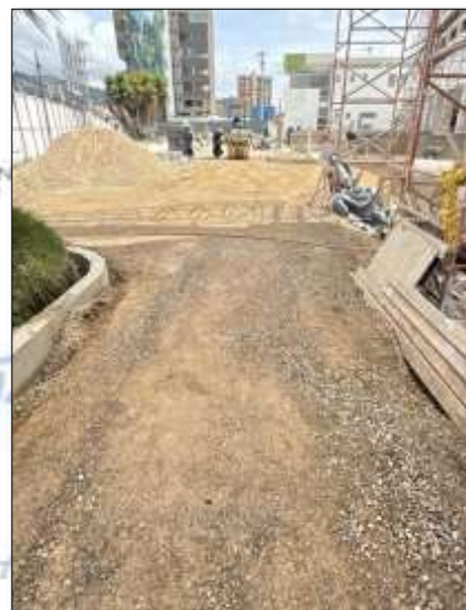
Imagen 64: Relleno con base granular
