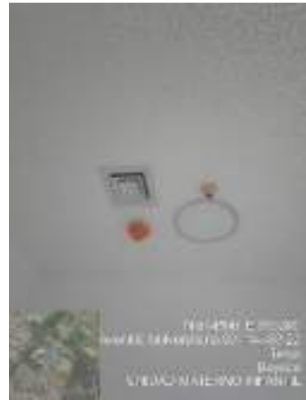
Imagen 8. Detector de humo fotoelectrico
