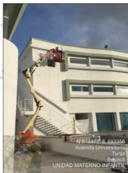
Imagen 66: Hounter Douglas fachada occidental
