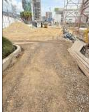
Imagen 38. Relleno con base granular
