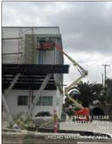
Imagen 38. Hounter Douglas fachada occidental
