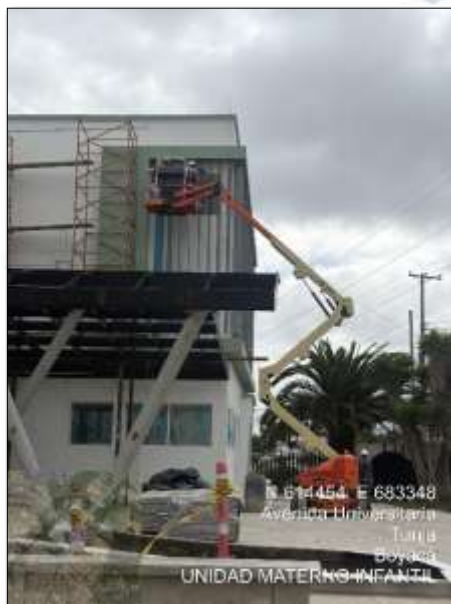
Imagen 65: Hounter Douglas fachada occidental
