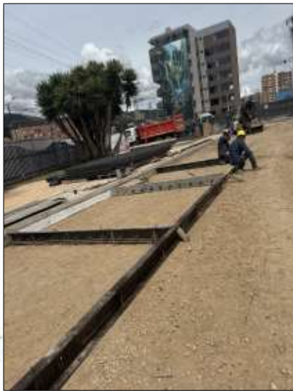
Imagen 63: Relleno con base granular
