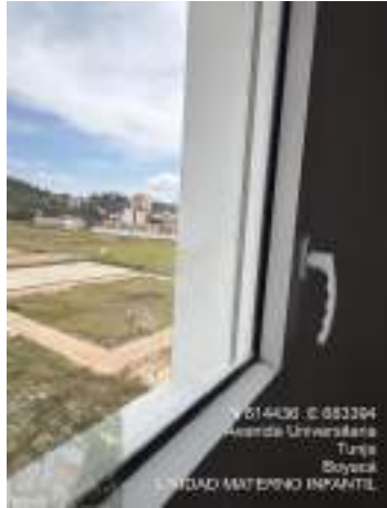
Imagen 1. Sellado de marcos de ventanería
