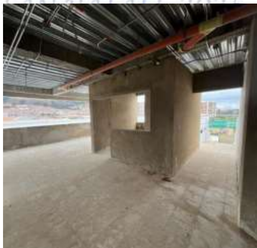
Imagen 42: Sala de espera
