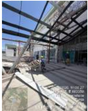
Imagen 28. Pergola fachada occidental
