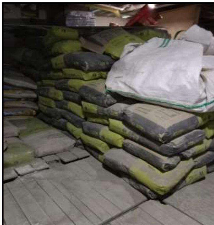
Ilustración 15. Acopio de cemento
