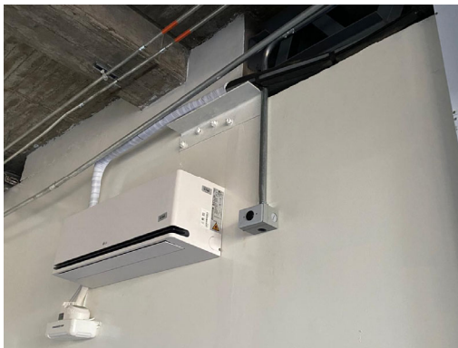
Puntos de tomacorriente, ducteria y cableado.
