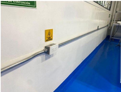
Puntos de tomacorriente, ducteria y cableado.
