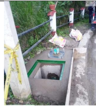
Ilustración 47 Terminación de caja
