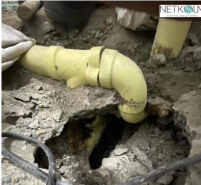
Ilustración 49 levantamiento de sanitarios
