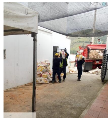
Ilustración 54 Recolección de escombros
