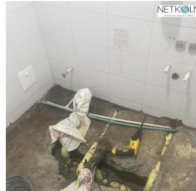
Ilustración 50 levantamiento de sanitarios
