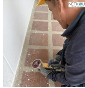
Ilustración 70 Inspección de Maquinaria
