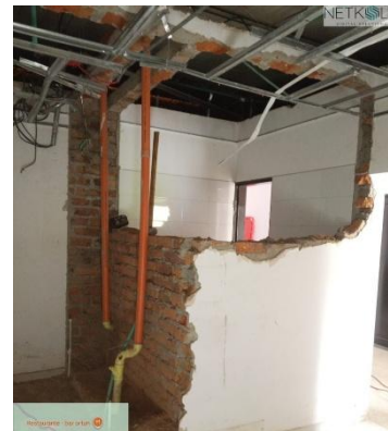
Ilustración 52 Demolición de muros
