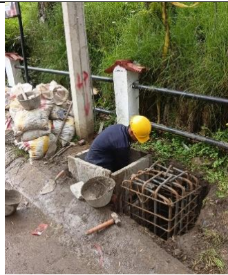
Ilustración 46 Realización de Base para LPR
