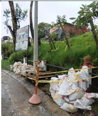
Ilustración 45 Inicio de excavación
