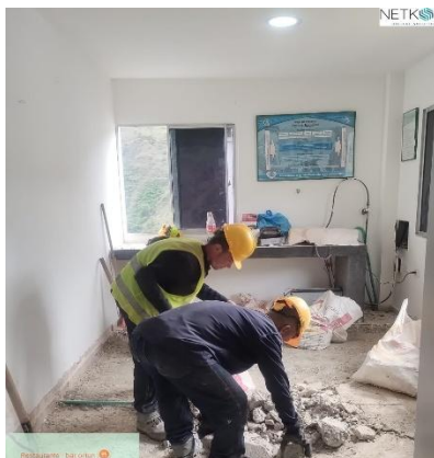
Ilustración 53 Trabajos de adecuación
