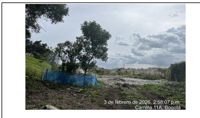
Foto N°4: Cerramiento de protección individual y colectiva– American Pipie
