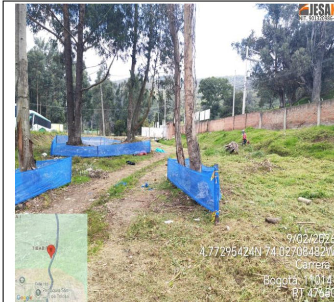
Foto N°3: Cerramiento de protección individual y colectiva– American Pipie
