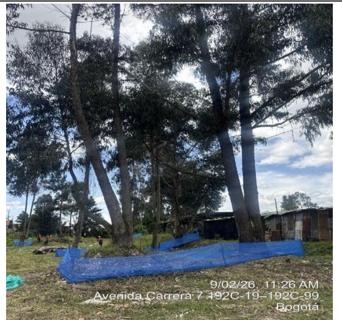
Foto N°4: Cerramiento de protección Corredor Verde – American Pipie
