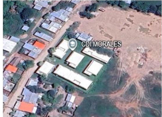
Fotografía 10. Vista área de las estructuras
