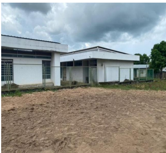
Fotografía 5. Estructura existente y cerramiento
