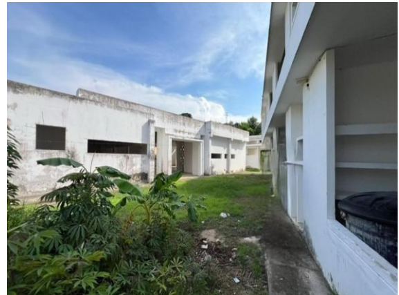
Fotografía 2. Vista estructuras existentes
