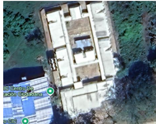
Fotografía 4. Vista área de las estructuras
