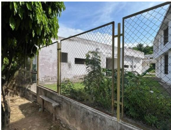
Fotografía 1. Estructuras existentes y cerramiento
