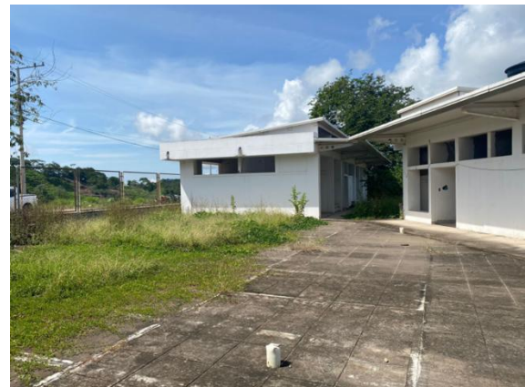
Fotografía 12. Vista de las estructuras
