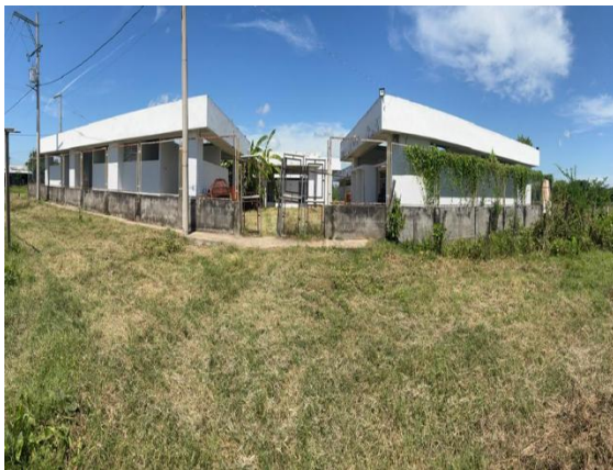
Fotografía 7. Estructura existente y cerramiento
