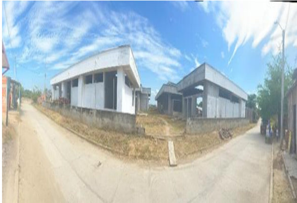
Fotografía 9. Estructura existente y cerramiento
