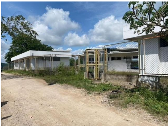
Fotografía 11. Estructura existente y cerramiento
