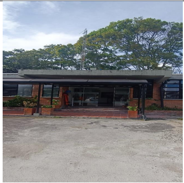
Fachada principal edificio contiguo a la sede administrativa del SGC caracterizada por sus grandes ventanales.
