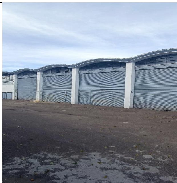
Aspecto general de grandes portones metálicos de bodegas con notoria falta de mantenimiento.
