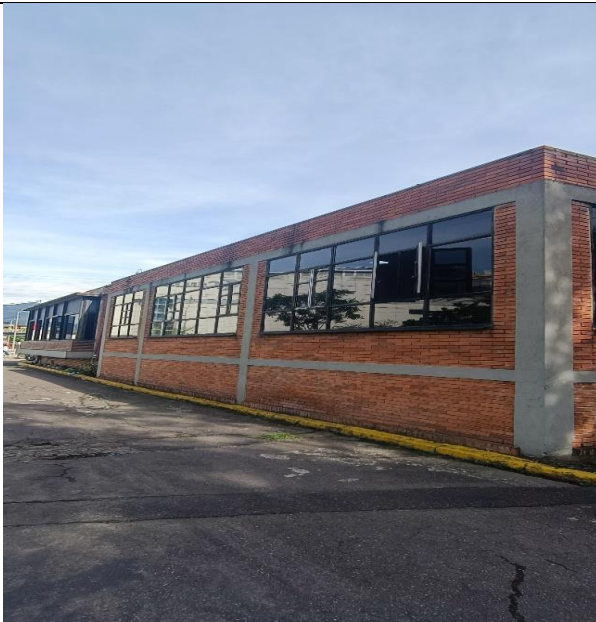
Fachada en ladrillo a la vista costado norte del edificio administrativo del SGC
