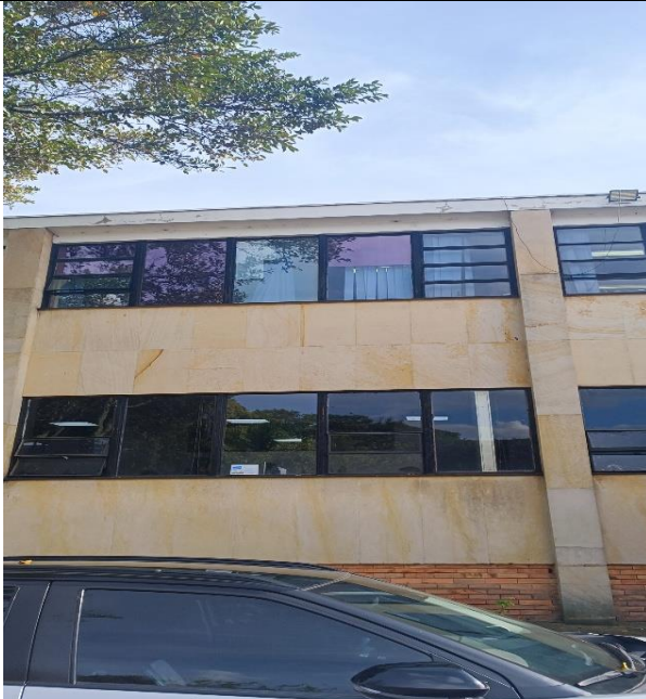
Fachada costado norte del edificio administrativo del SGC cuyo material es Piedra muñeca o Piedra Bogotana. Esta piedra es una arenisca natural de color amarillo ocre valorada por su resistencia y estética.
