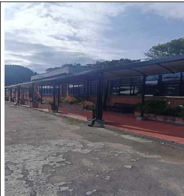
Fachada en ladrillo a la vista y grandes ventanales.
