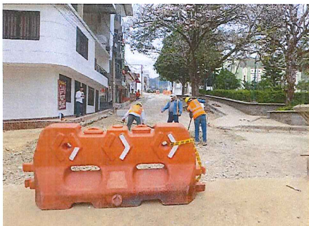
Conformación de la subrasante en calle 10
