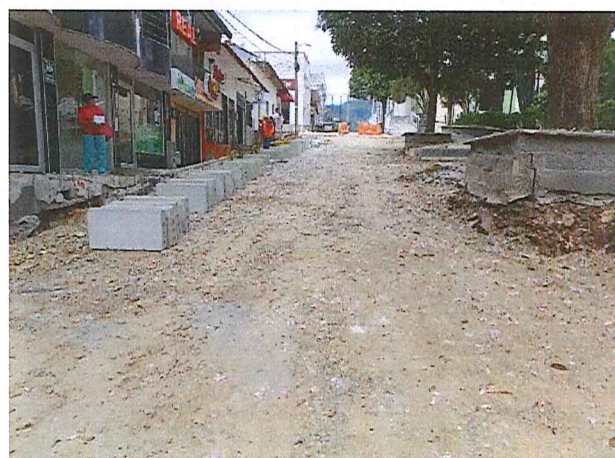
Base estabilizada en la carrera 3
