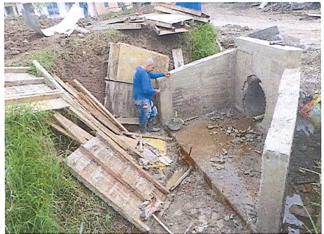
Construcción de descole de alcantarilla en Calle 4
