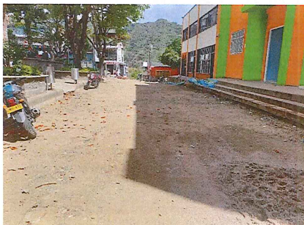
Base estabilizada en la Calle 10
