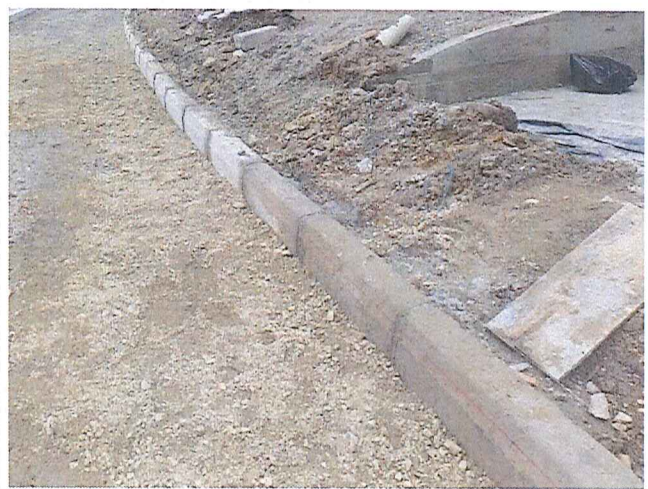
Sardineles y base instalados sobre calle 4
