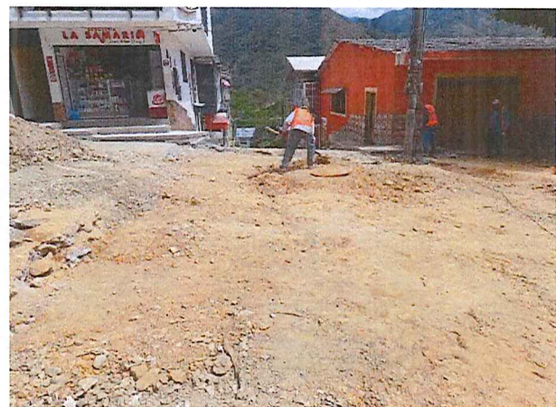
Excavación en el tramo final de la calle 10
