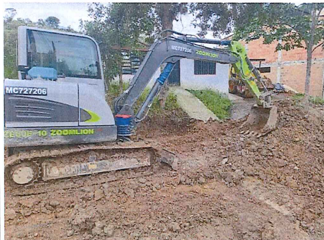
Excavación en calle 4 entre carreras 13A y 12A
