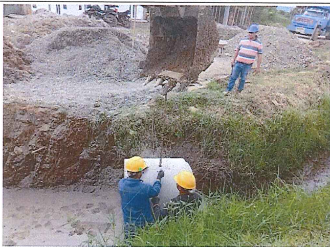
Solado para cama de tubería de 36" en Calle 4
