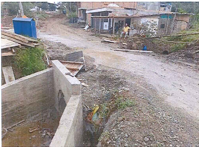
Afirmado sobre la tubería instalada de la alcantarilla en Calle 4
