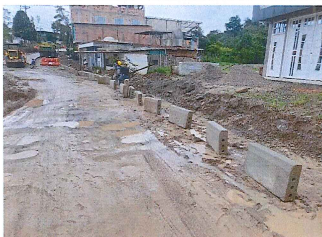
Instalación de sardineles en calle 4
