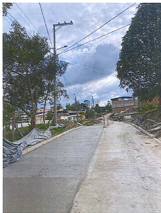
Fundición del último tramo calle 4
