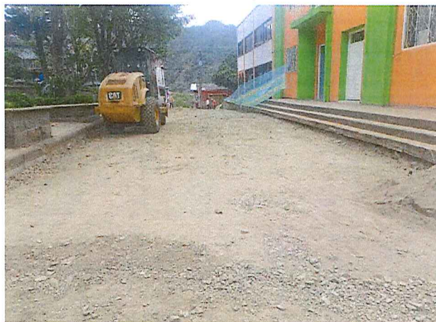
Conformación de la subrasante en calle 10
