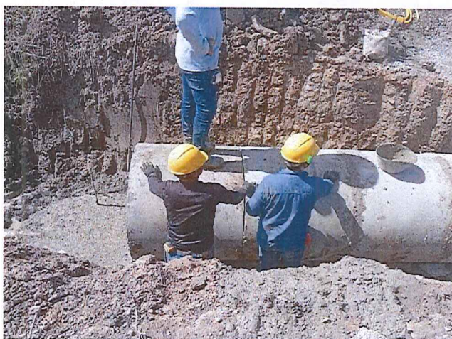
Instalación de tubería 36" para alcantarilla en calle 4
