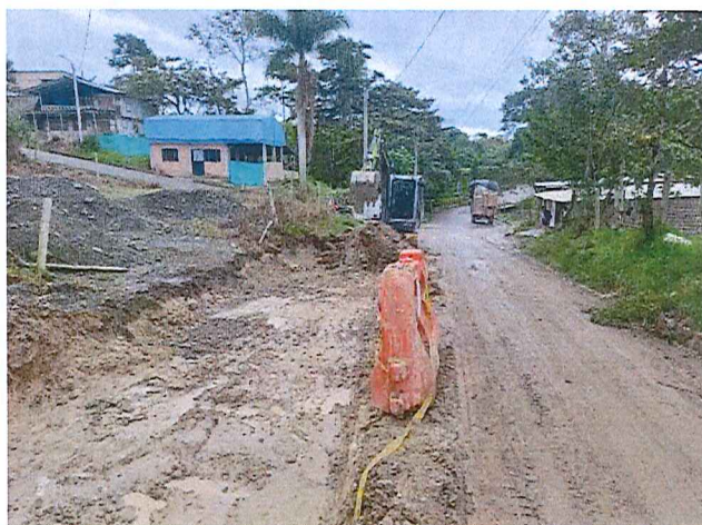
Excavación en calle 4
