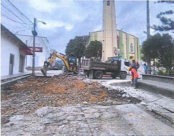
Demolición de pavimento existente
