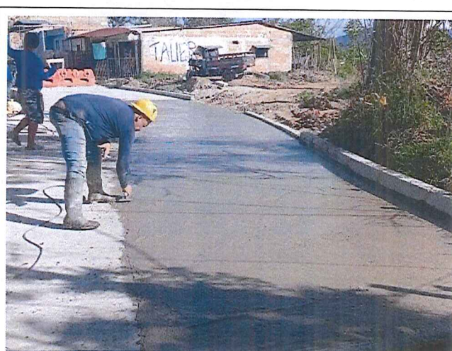
Fundición concreto MR-38 Cra. 13A
