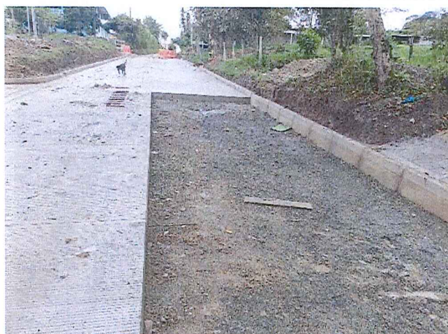
Tramo listo para fundir en calle 4
