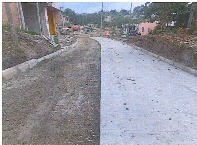
Fundición de carril en calle 4 entre Cra. 13A y 12A
