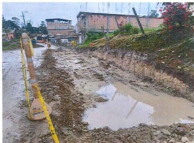
Excavación en calle 4 con terreno saturado debido a las constantes lluvias
