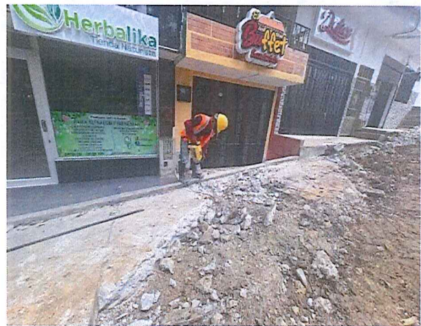
Demolición de pavimento existente
