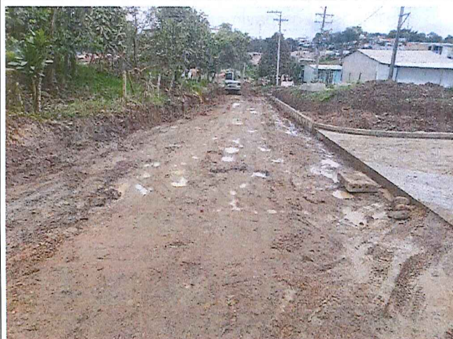
Conformación de la calle 4 entre carreras 13A y 12A
