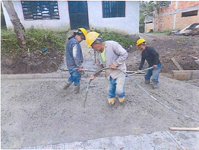
Vibrado de concreto en calle 4
