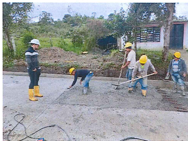
Fundición e instalación de dovelas en calle 4
