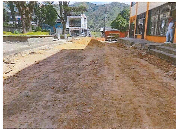
Demolición terminada en calle 10
