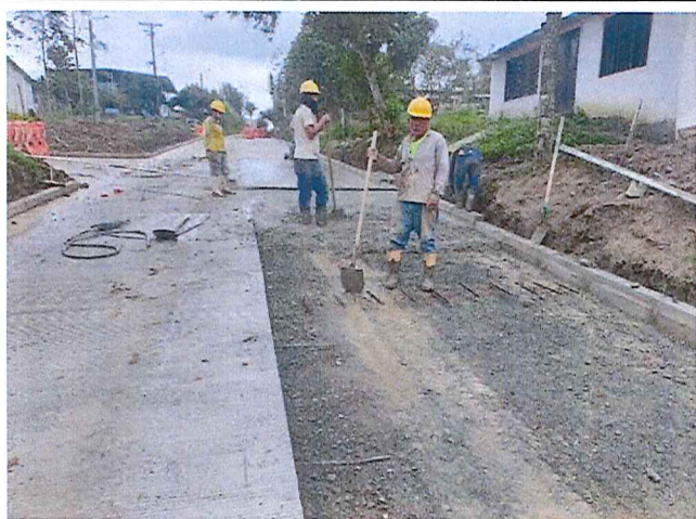
Fundición e instalación de dovelas en calle 4
