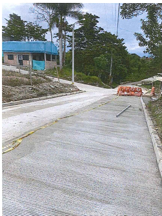
Culminación de actividades de pavimento
