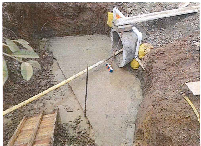
Construcción de descole de alcantarilla sobre calle 4
