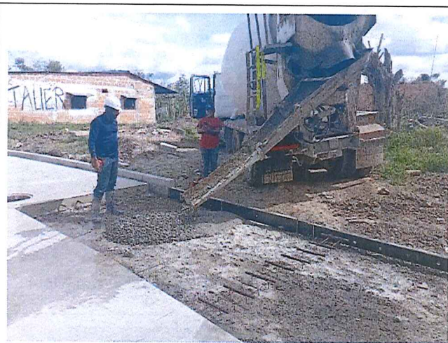
Instalación de barras lisas Cra. 13A
