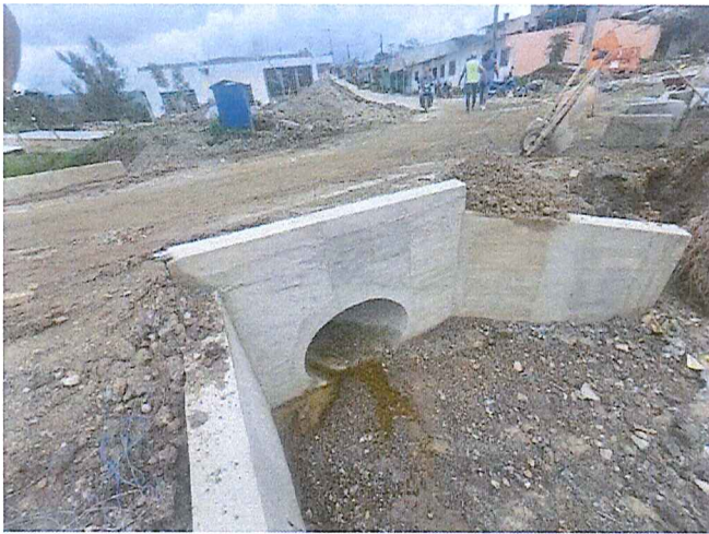
Estructura inicial de alcantarilla sobre calle 4
