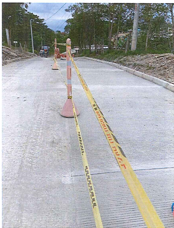
Culminación de actividades de pavimento
