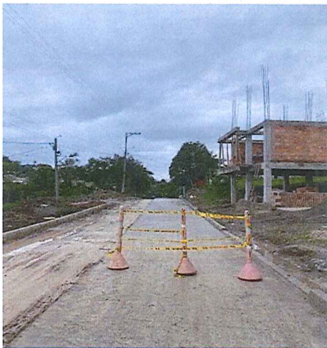
Tramo de calle 4 fundido, faltando aproximadamente 80 metros
