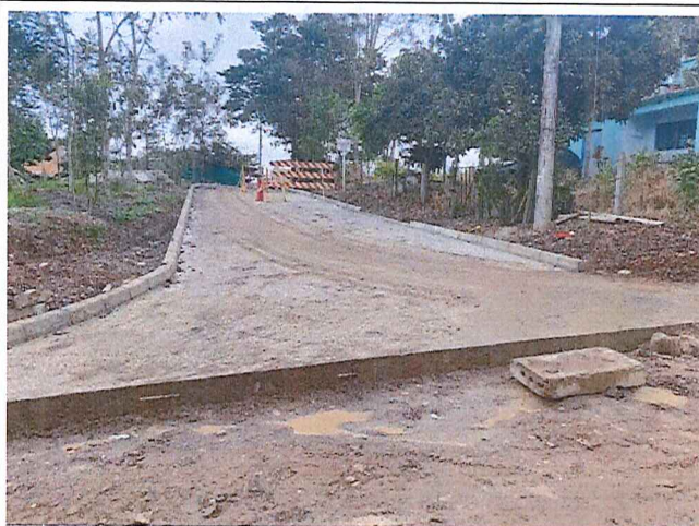
Culminación de pavimento en carrera 13A
