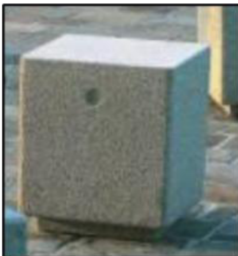
Ilustración 63. Detalle de bolardo cúbico
