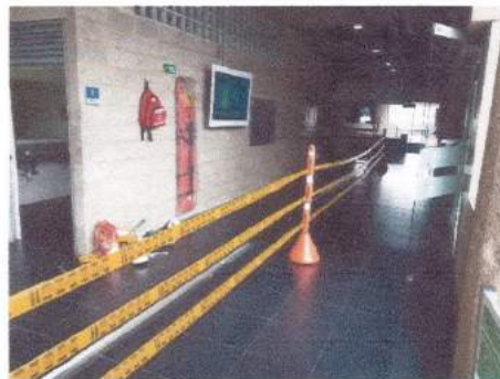
Fotografía 6: Señalización y delimitación Interna en cada uno de los frentes de obra. Fuente: Sisoma Khalifa
