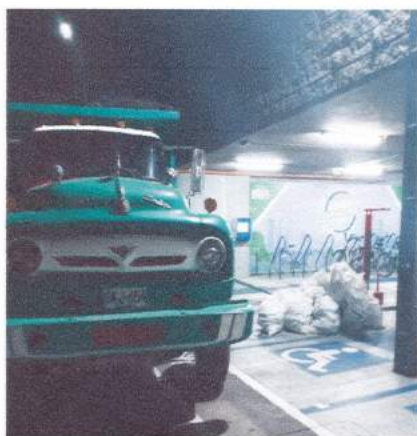
Fotografía 9: Se realiza la disposición adecuada de los escombros generados. Fuente: Sisoma Khalifa Ingeniería y Construcciones S.A.S.
