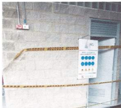
Fotografía 5: Señalización y delimitación Interna en cada uno de los frentes de obra. Fuente: Sisoma Khalifa
