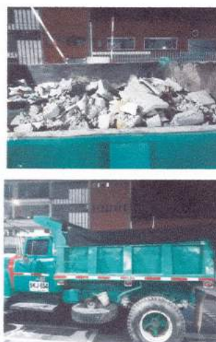
Fotografía 10-11: Se cuenta con la certificación de disposición de escombros. Fuente: Sisoma Khalifa Ingeniería y Construcciones S.A.S.
