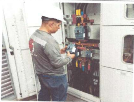
Foto No: 11 Observaciones Particulares: Suministro e Instalación de Contacto Trifásico 250A 11B25000220 BOBINA 22VAC
