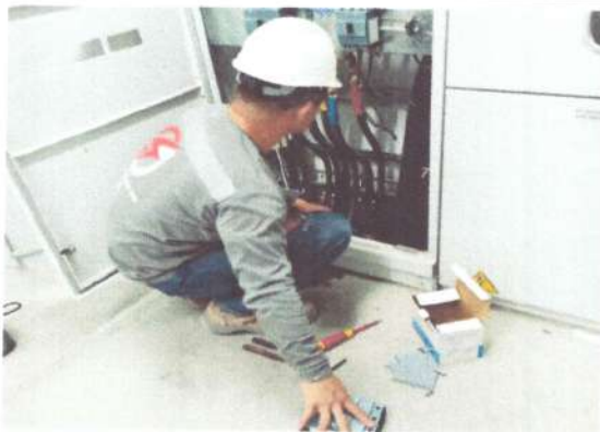
Foto No: 7 Observaciones Particulares: Suministro e Instalación de Contacto Trifásico 250A 11B25000220 BOBINA 22VAC
