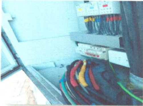
Foto No: 9 Observaciones Particulares: Suministro e Instalación de dps Protección Contra Tensiones Tipo 1+2 Polos / BR 12.5M 4P- MASTIL No.2
