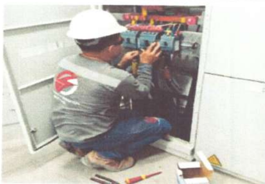
Foto No: 5 Observaciones Particulares: Suministro e Instalación de Contacto Trifásico 250A 11B25000220 BOBINA 22VAC
