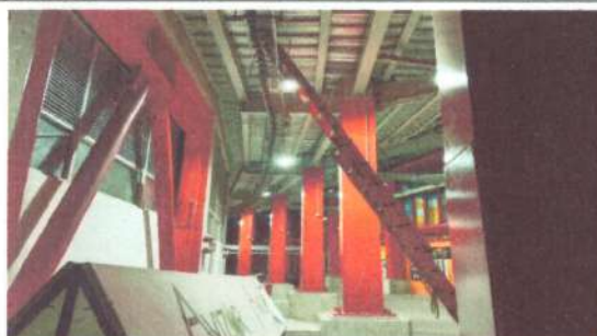
Foto No: 20 Observaciones Particulares: Suministro E Instalacion Luminaria High Bay 200w
