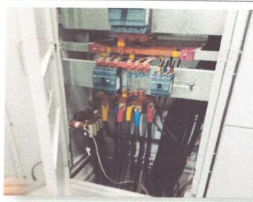
Foto No: 8 Observaciones Particulares: Suministro e Instalación de Contacto Trifásico 250A 11B25000220 BOBINA 22VAC
