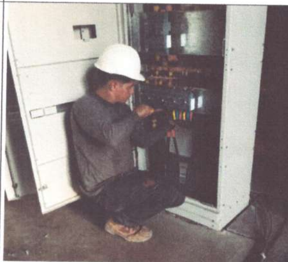
Instalación de Contacto Trifásico 250A 11B25000220 BOBINA 22VAC
