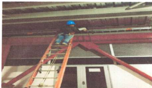
Foto No: 11 Observaciones Particulares: Suministro E Instalacion Luminaria High Bay 200w
