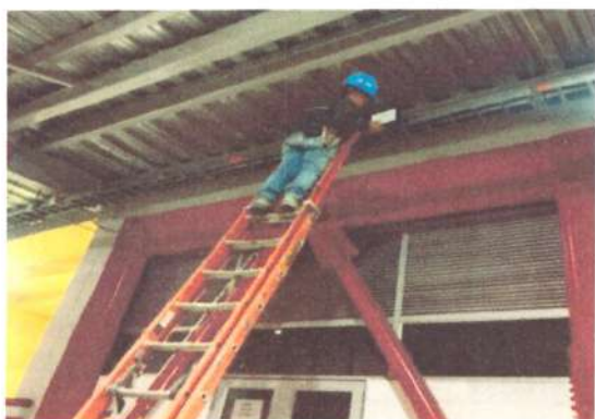
Foto No: 3 Observaciones Particulares: Suministro E Instalacion Luminaria High Bay 200w
