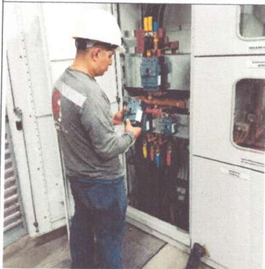
Instalación de Contacto Trifásico 250A 11B25000220 BOBINA 22VAC
