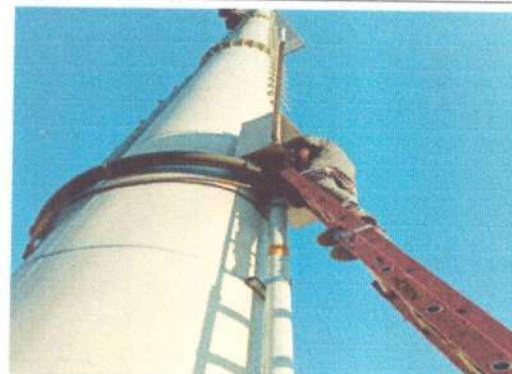
Foto No: 12 Observaciones Particulares: Suministro e Instalación de dps Protección Contra Tensiones Tipo 1+2 Polos / BR 12.5M 4P- MASTIL No.2
