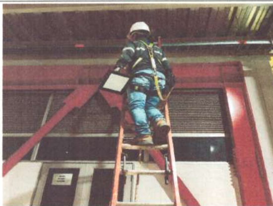
Foto No: 2 Observaciones Particulares: Suministro E Instalacion Luminaria High Bay 200w
