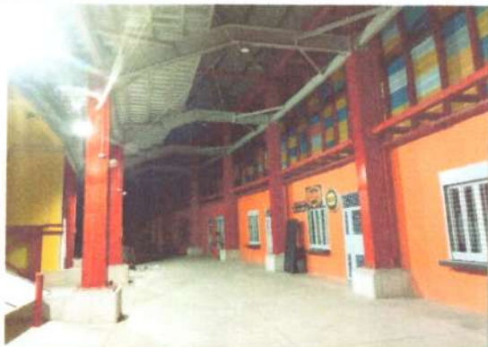
Foto No: 13 Observaciones Particulares: Suministro E Instalacion Luminaria High Bay 200w
