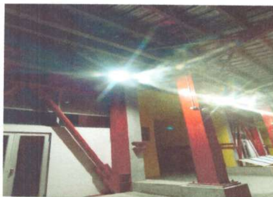
Foto No: 16 Observaciones Particulares: Suministro E Instalacion Luminaria High Bay 200w
