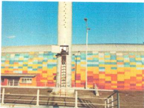
Foto No: 11 Observaciones Particulares: Suministro e Instalación de dps Protección Contra Tensiones Tipo 1+2 Polos / BR 12.5M 4P- MASTIL No.2
