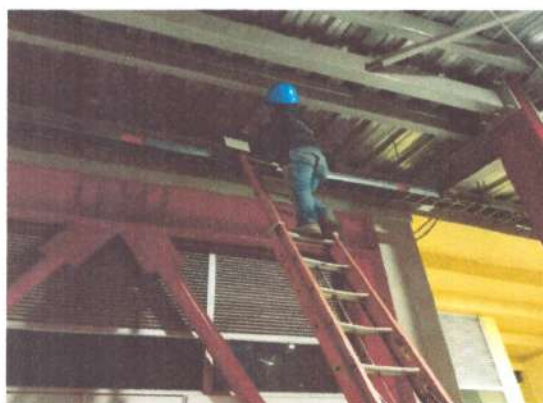
Foto No: 4 Observaciones Particulares: Suministro E Instalacion Luminaria High Bay 200w
