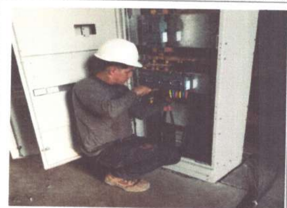
Foto No: 15 Observaciones Particulares: Suministro e Instalación de Contacto Trifásico 250A 11B25000220 BOBINA 22VAC
