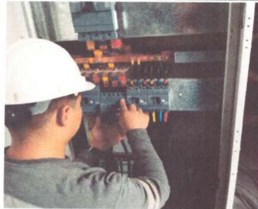
Foto No: 6 Observaciones Particulares: Suministro e Instalación de Contacto Trifásico 250A 11B25000220 BOBINA 22VAC
