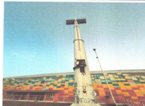
Foto No: 10 Observaciones Particulares: Suministro e Instalación de dps Protección Contra Tensiones Tipo 1+2 Polos / BR 12.5M 4P- MASTIL No.2
