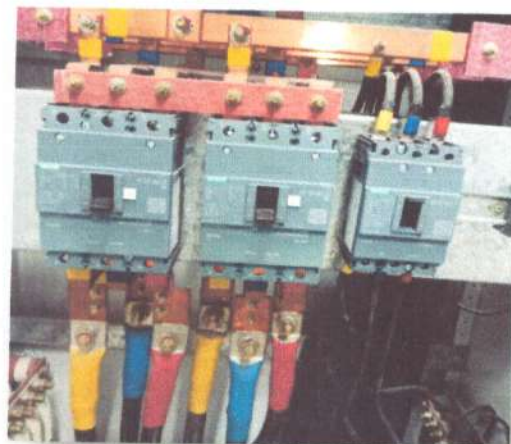
Instalación de Contacto Trifásico 250A 11B25000220 BOBINA 22VAC
