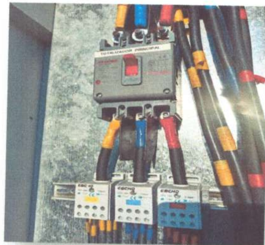
Instalación de DPS Protección Contra Tensiones Tipo 1+2 Polos / BR 12.5M 4P-
