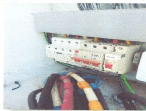
Foto No: 8 Observaciones Particulares: Suministro e Instalación de dps Protección Contra Tensiones Tipo 1+2 Polos / BR 12.5M 4P- MASTIL No.2
