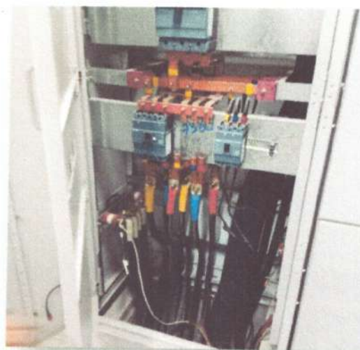
Instalación de Contacto Trifásico 250A 11B25000220 BOBINA 22VAC
