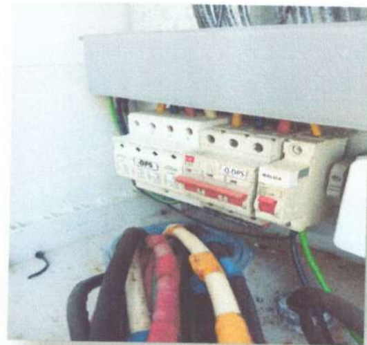
Instalación de DPS Protección Contra Tensiones Tipo 1+2 Polos / BR 12.5M 4P-
