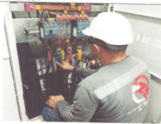
Foto No: 12 Observaciones Particulares: Suministro e Instalación de Contacto Trifásico 250A 11B25000220 BOBINA 22VAC
