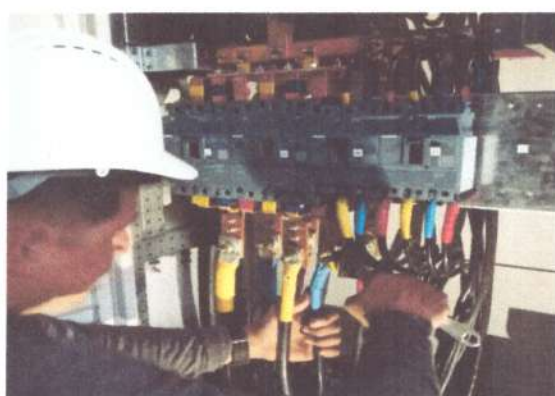
Foto No: 1 Observaciones Particulares: Suministro e Instalación de Contacto Trifásico 250A 11B25000220 BOBINA 22VAC
