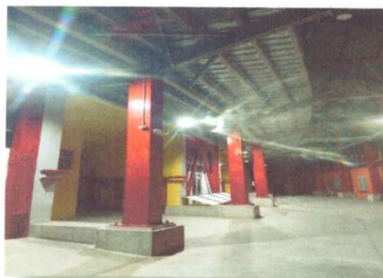
Foto No: 14 Observaciones Particulares: Suministro E Instalacion Luminaria High Bay 200w
