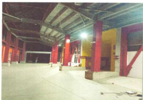
Foto No: 15 Observaciones Particulares: Suministro E Instalacion Luminaria High Bay 200w
