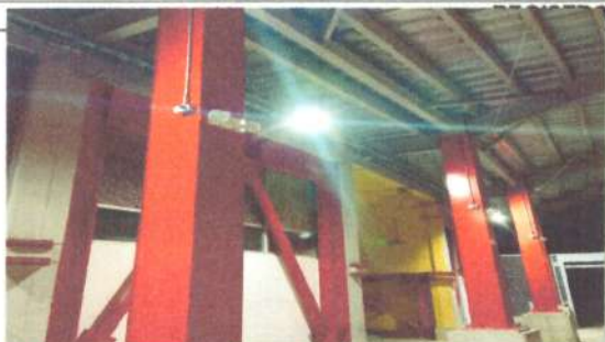
Foto No: 19 Observaciones Particulares: Suministro E Instalacion Luminaria High Bay 200w
