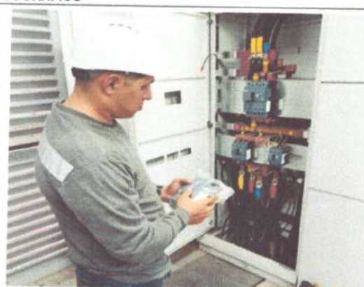
Foto No: 10 Observaciones Particulares: Suministro e Instalación de Contacto Trifásico 250A 11B25000220 BOBINA 22VAC
