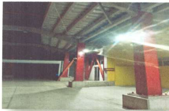
Foto No: 12 Observaciones Particulares: Suministro E Instalacion Luminaria High Bay 200w
