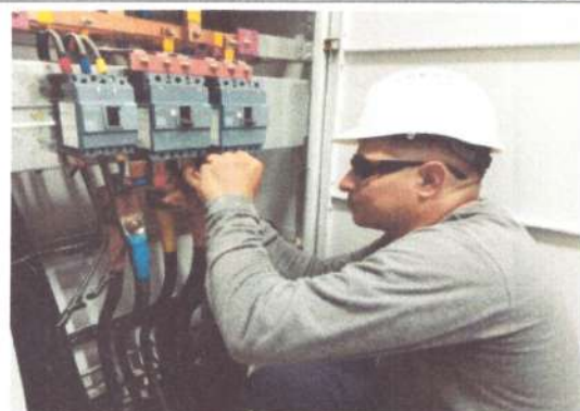
Foto No: 3 Observaciones Particulares: Suministro e Instalación de Contacto Trifásico 250A 11B25000220
