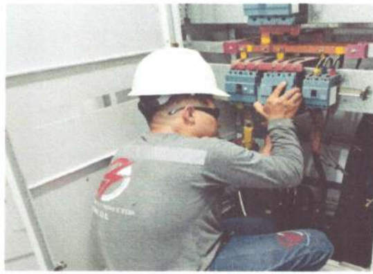
Foto No: 2 Observaciones Particulares: Suministro e Instalación de Contacto Trifásico 250A 11B25000220 BOBINA 22VAC
