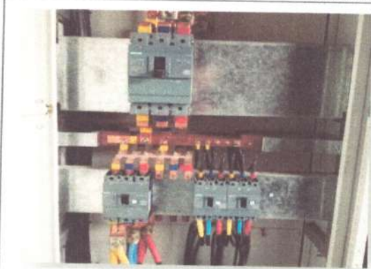
Foto No: 9 Observaciones Particulares: Suministro e Instalación de Contacto Trifásico 250A 11B25000220 BOBINA 22VAC
