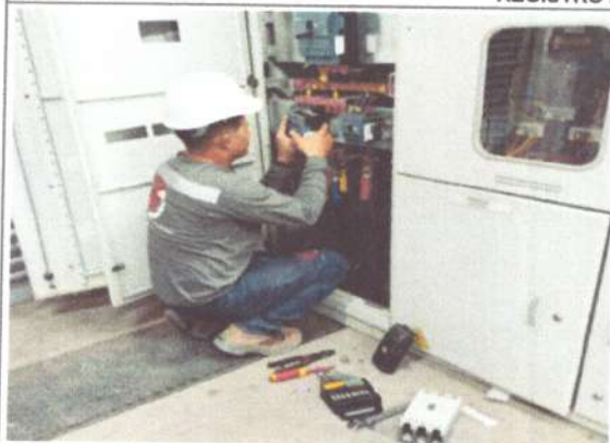
Foto No: 13 Observaciones Particulares: Suministro e Instalación de Contacto Trifásico 250A 11B25000220 BOBINA 22VAC
