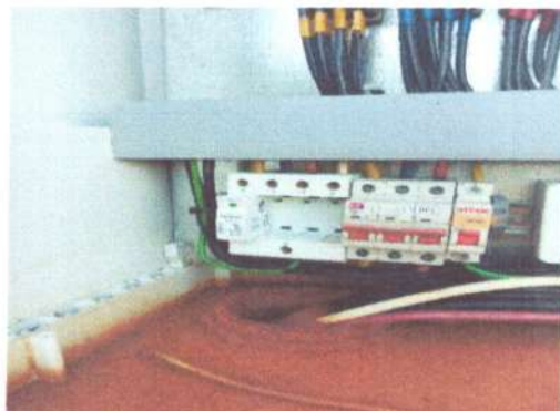
Foto No: 5 Observaciones Particulares: Suministro e Instalación de dps Protección Contra Tensiones Tipo 1+2 Polos / BR 12.5M 4P- MASTIL No.2
