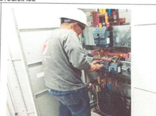
Foto No: 14 Observaciones Particulares: Suministro e Instalación de Contacto Trifásico 250A 11B25000220 BOBINA 22VAC
