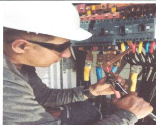
Foto No: 4 Observaciones Particulares: Suministro e Instalación de Contacto Trifásico 250A 11B25000220
