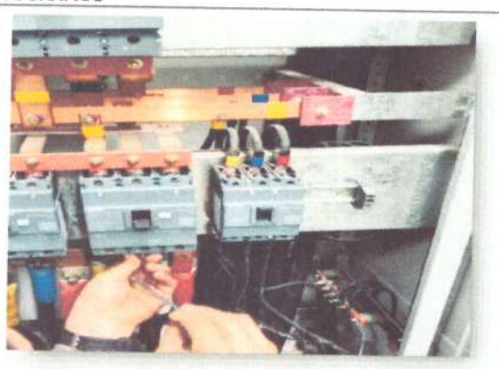
Foto No: 16 Observaciones Particulares: Suministro e Instalación de Contacto Trifásico 250A 11B25000220 BOBINA 22VAC
