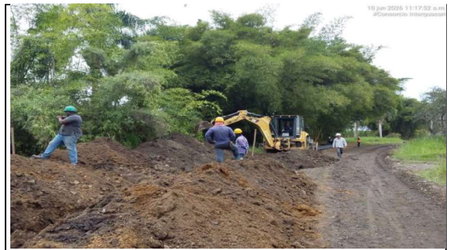
EXCAVACION PARA PASE TRAMO 3 TUBERIA PEAD 14 PULGADAS - PICHICHI
