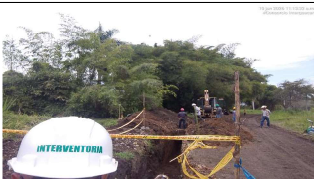
EXCAVACION PARA PASE TRAMO 3 TUBERIA PEAD 14 PULGADAS - PICHICHI
