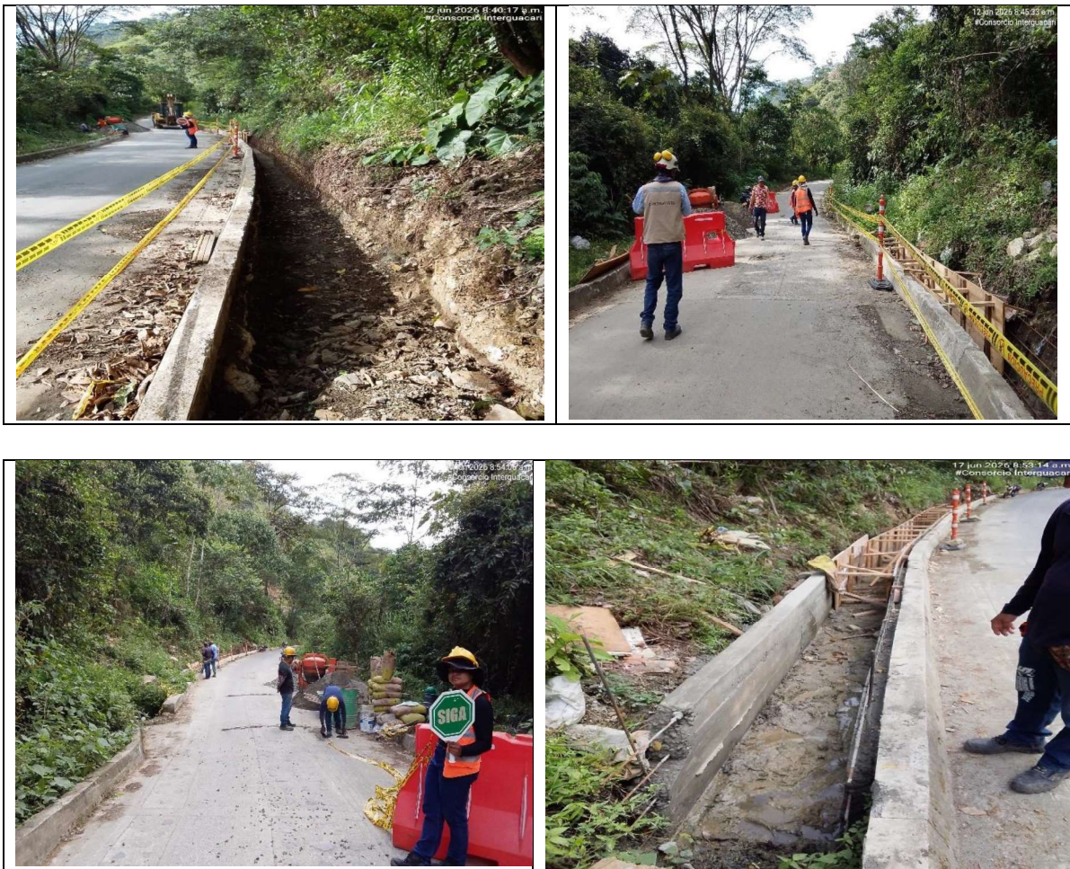
Fundición cárcamo entre las K1+170 a K1+250
