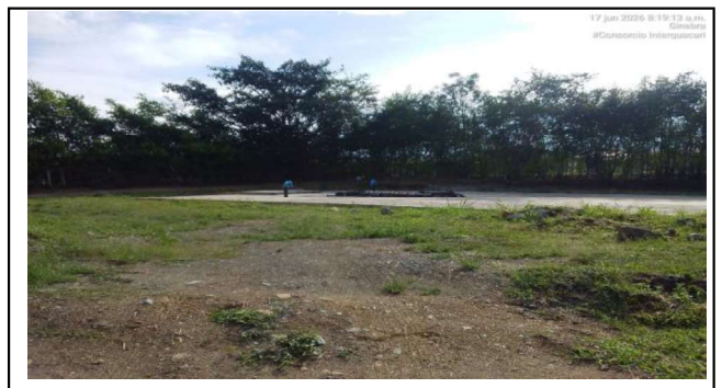
ESTADO ACTUAL TANQUE DE ALMACENAMIENTO LA ALBANIA
