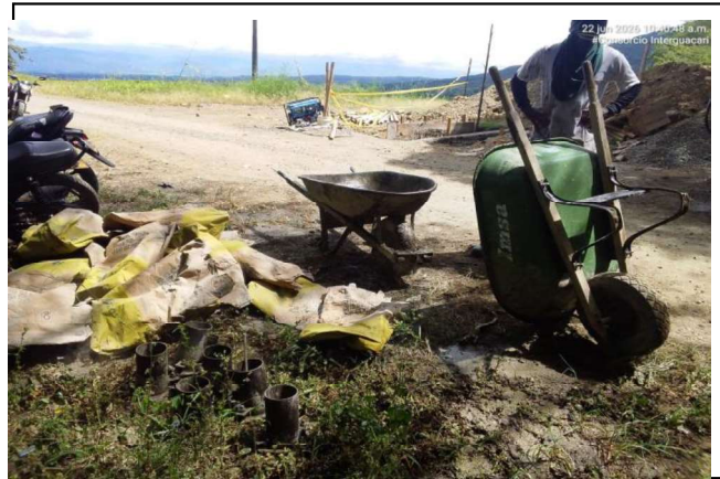
FUNDICION CAMARA DE VENTOSA TRAMO 3
