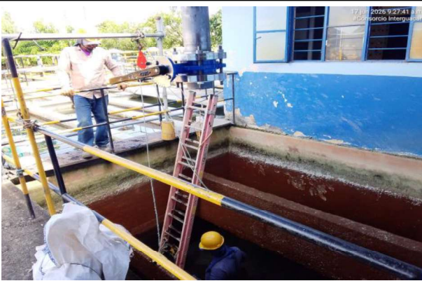
INICIO DE INTERVENCION FILTRACION MODULO A PTAP GUACARI CON RETIRO DE MATERIAL ANTRACITA
