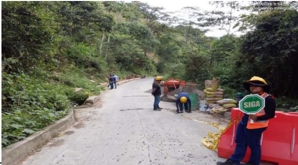
INICIO DE FUNDICION CARCAMO TRAMO 1 TUBERIA PEAD 18 PULGADAS
