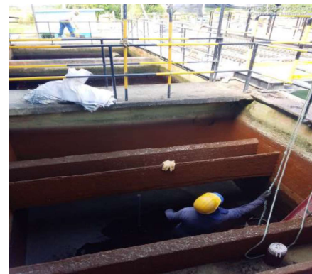
INICIO DE INTERVENCION FILTRACION MODULO A PTAP GUACARI CON RETIRO DE MATERIAL GRAVA
