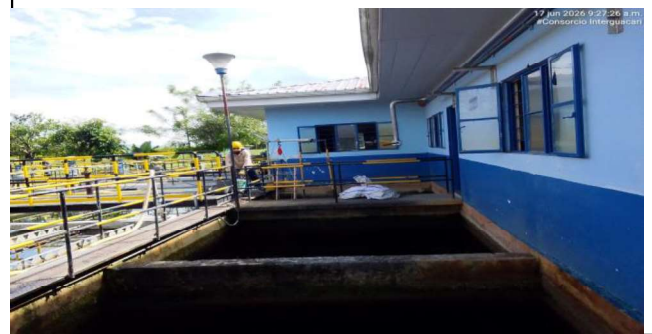
INICIO DE INTERVENCION FILTRACION MODULO A PTAP GUACARI CON RETIRO DE MATERIAL ANTRACITA
