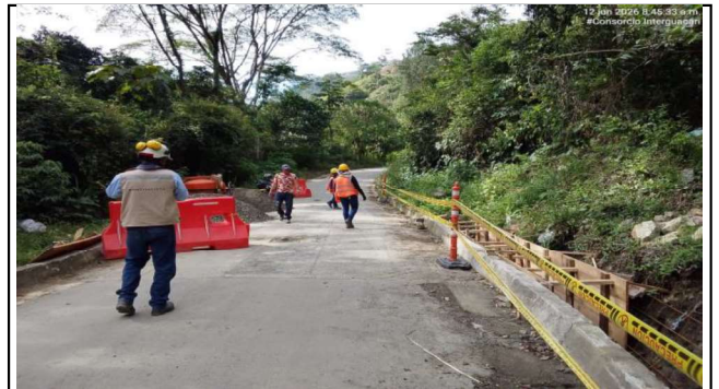
COLOCACION FORMALETA CARCAMO TRAMO 1 TUBERIA 18 PULGADAS
