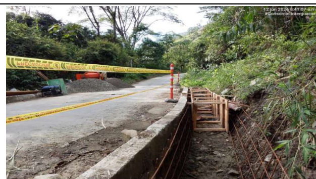
COLOCACION FORMALETA CARCAMO TRAMO 1 TUBERIA 18 PULGADAS
