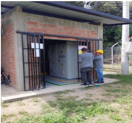
COLOCACION DE SEÑALES CASETA ELECTRICA PTAP GUACARI
