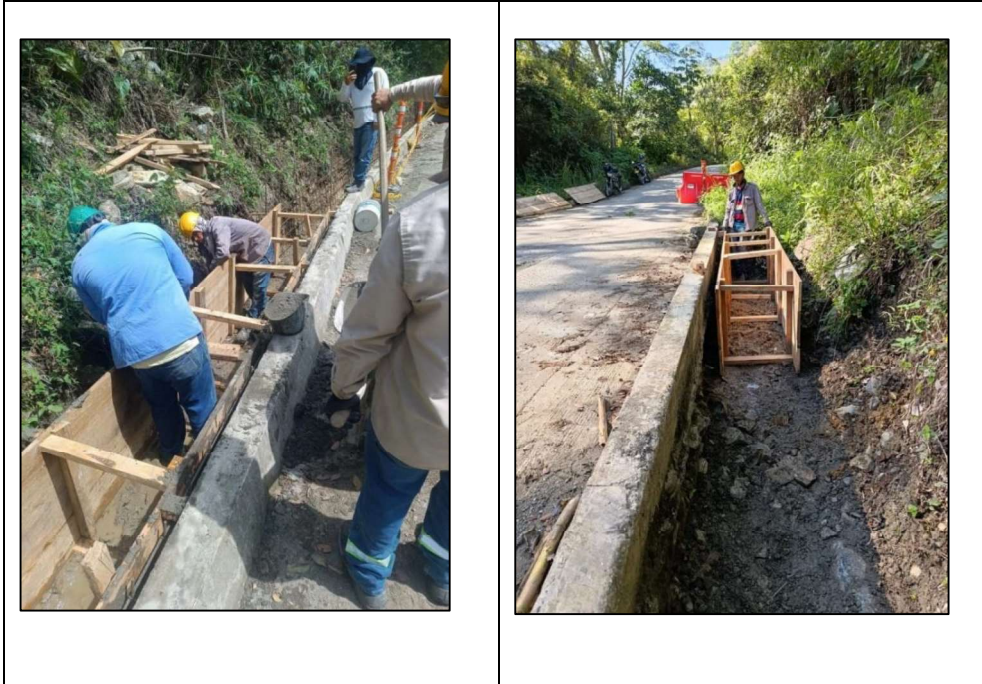
Fotos N°2 y 3. Construcción de un cárcamo lateral
