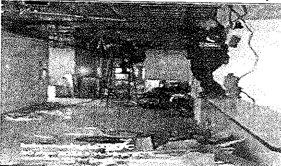
Desmante de cielo raso y retiro de cableado eléctrico
