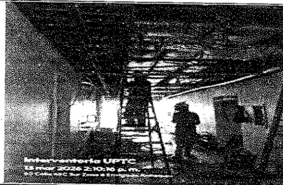
Desmante de ductos y estructura de cielo raso existente
