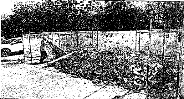
Retiro y acopio de RCD
