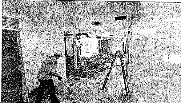
Demolición de muros
