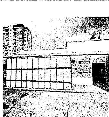
Cerramiento en Dry walll
