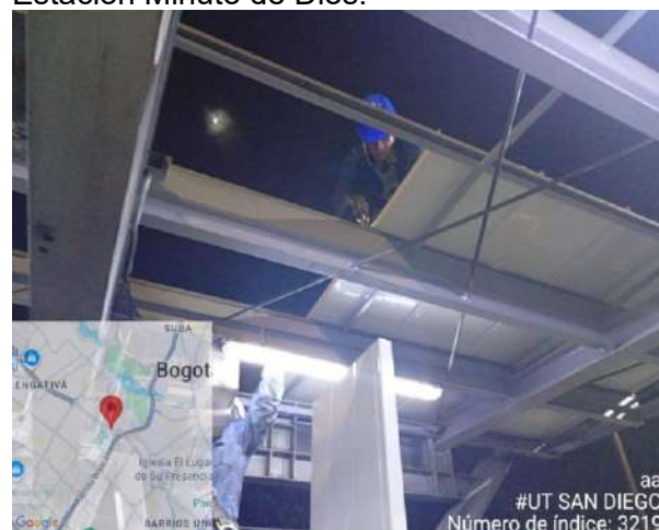
Figura 29 Instalación de cubierta en la Estación Minuto de Dios.
