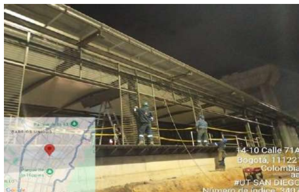
Figura 34 Instalación de celosías Estación Calle 72.
