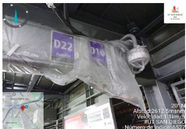
Figura 160 Medida preventiva de dispersión de material particulado - Estación Boyacá.
