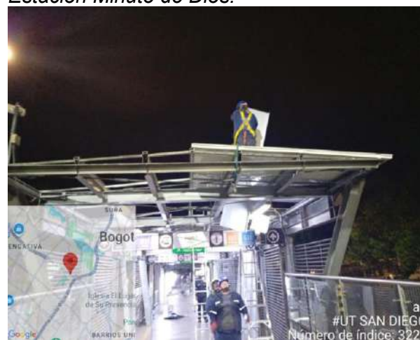
Figura 30 Instalación de cubierta en la Estación Minuto de Dios.
