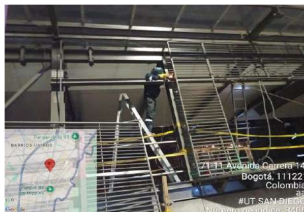
Figura 35 Instalación de celosías Estación Calle 72.
