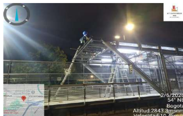
Figura 27 Instalación de cubierta en la Estación Minuto de Dios.
