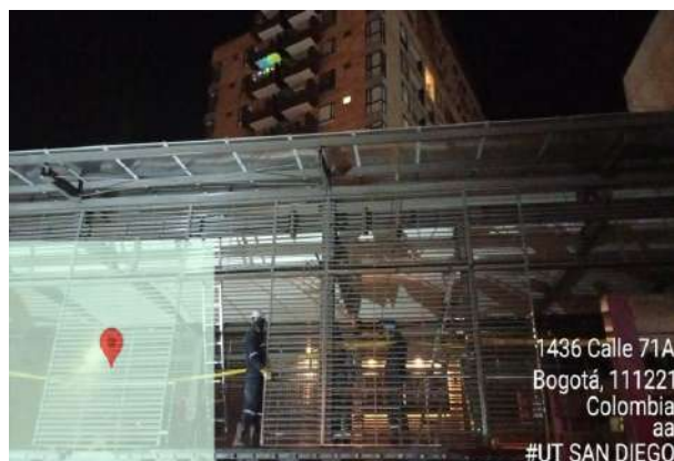
Figura 36 Instalación de celosías Estación Calle 72.
