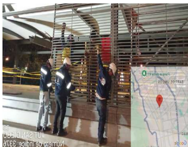
Figura 36 Instalación de celosías Estación Calle 72.
