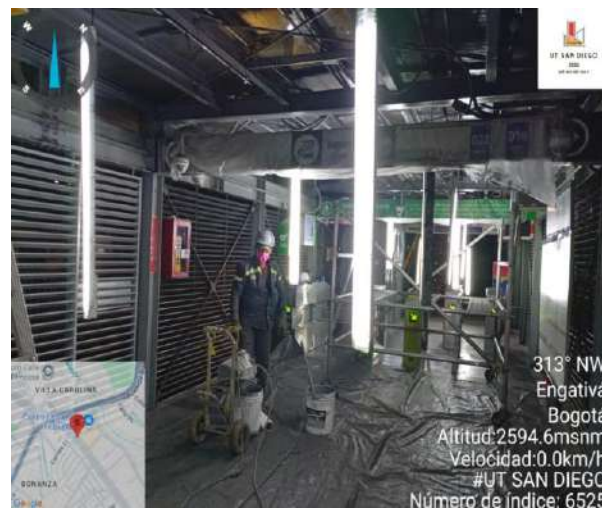
Figura 163 Medida preventiva de dispersión de material particulado - Estación Boyacá.
