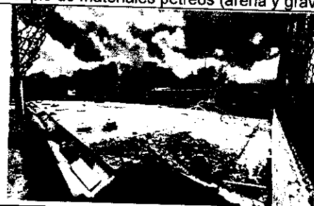
Panorámica de obra
