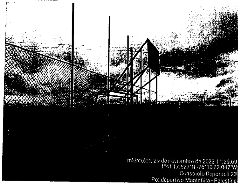
Imagen 1 – Fotografía que ilustra el poste y línea de BT a remover.
