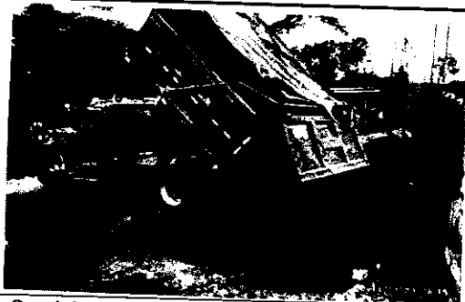
Suministro de material (arena) para concretos
