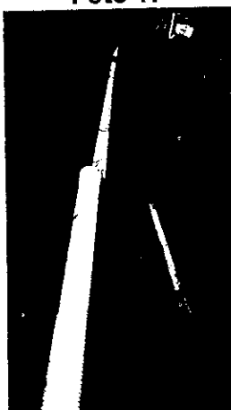
Instalación tubería PVC-S de 6"
