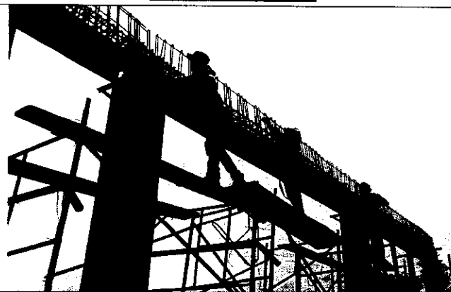
Montaje acero de refuerzo viga canal eje B
