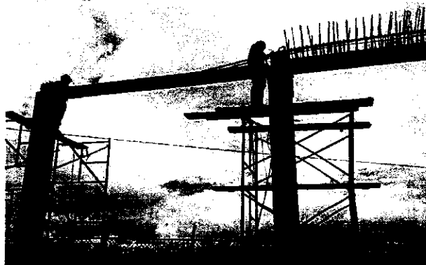
Instalación de formaleta metálica para viga canal Eje B
