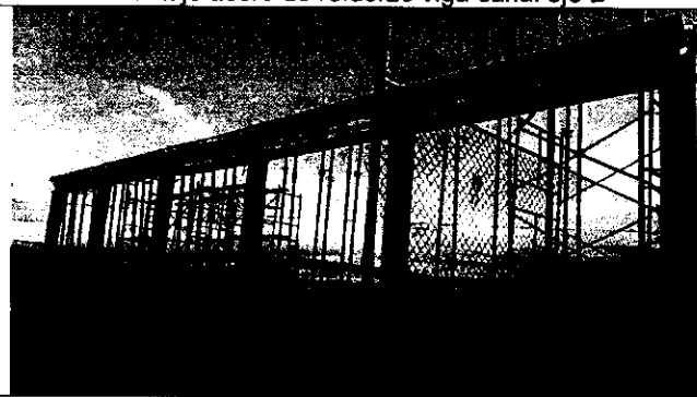
Instalación formaleta metálica Viga canal Eje B
