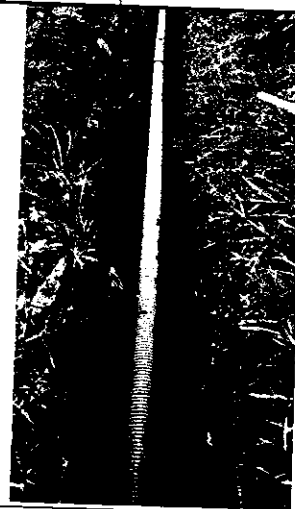
Instalación tubería PVC-S de 6"
