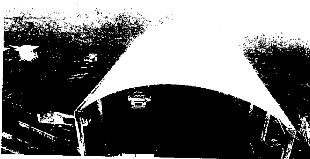
Cubierta Autoportante Instalada
