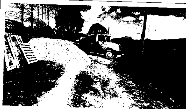
Aislamiento de la obra
