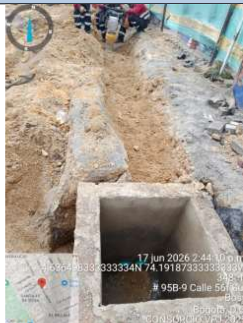
Construcción de caja de inspección para alumbrado público y acometidas en baja norma codensa cs 274 (norma 2018-2019) CIV 7000386
