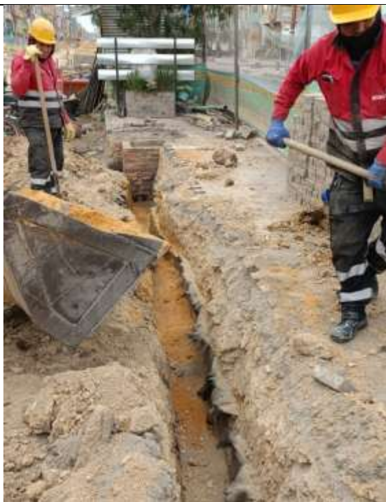
Relleno para redes en subbase granular b-200 CIV 7000325
