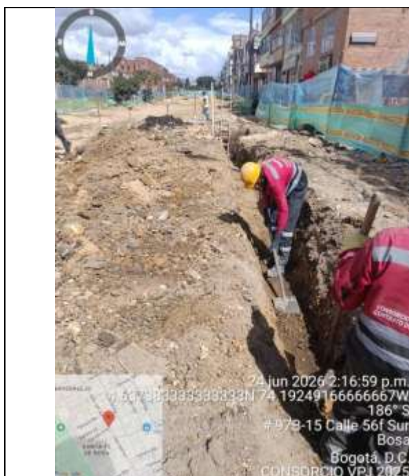
Excavación manual en material común (incl cargue, transporte y disposicion final) CIV 7000301
