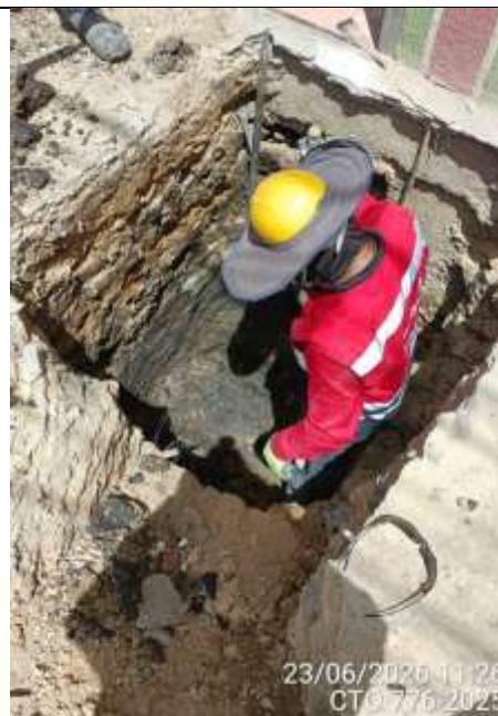
Base y cañuela para caja en concreto reforzado 0,7x0,7m construida in-situ CIV 7000247
