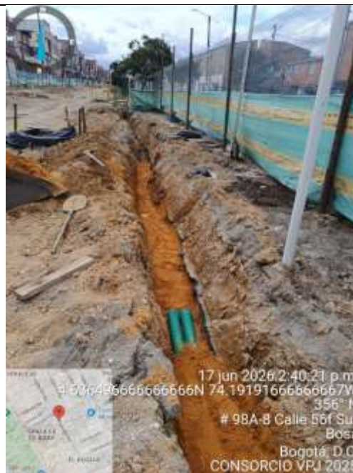
Relleno para redes en arena de Peña (suministro, extendido, humedecimiento y compactación) CIV 7000386
