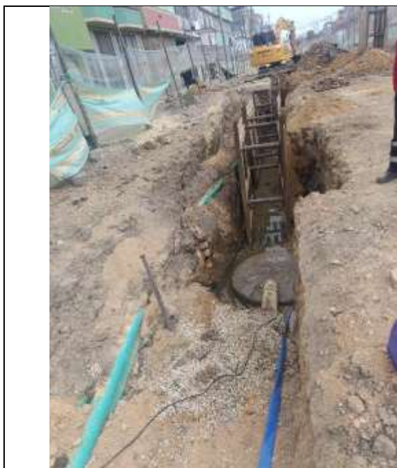
Placa fondo d=1.70m pozo inspec. CIV 7000247
