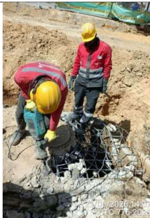
Demolición de pozos, cajas y cámaras de empresas de servicios públicos CIV 7000301
