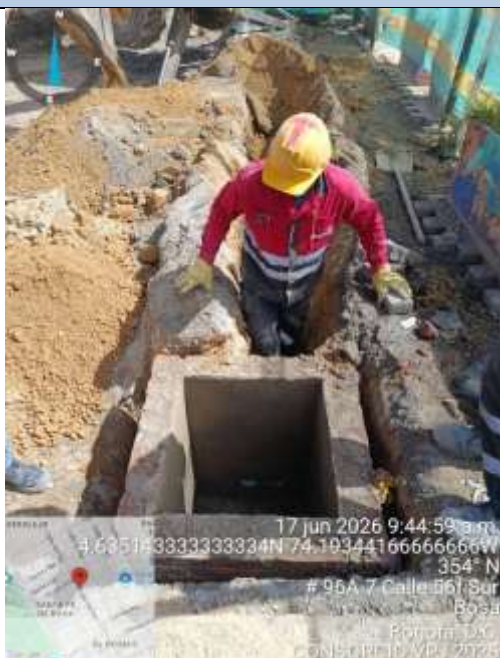
Construcción de caja de inspección para alumbrado público y acometidas en baja
