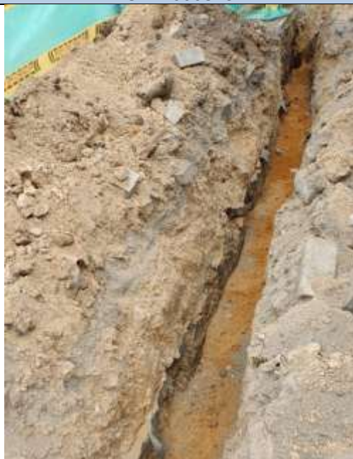
Relleno para redes en arena de peña (suministro, extendido, humedecimiento y compactación) CIV 7000325
