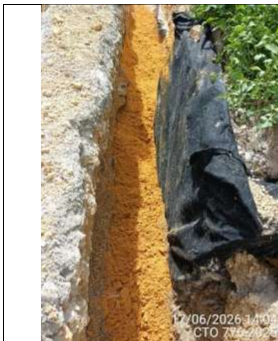
Relleno para redes en arena de Peña (suministro, extendido, humedecimiento y compactación) CIV 7000386
