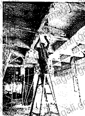
NP5 Desmonte de Cableado Eléctrico. Incluye tubería y demás accesorios eléctricos
