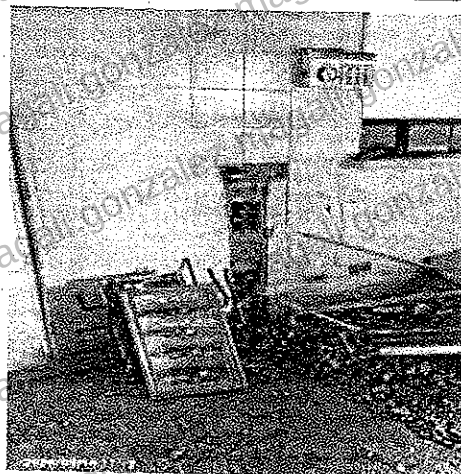
ITEM 5.2.2 Retiro y desmonte de caja de corte actuales
