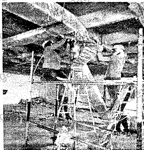
ITEM 5.2.1 Desmonte de redes de gases medicinales existentes de 1/2" a 2"
