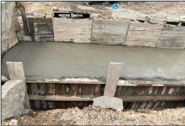
Concreto para carcamo
