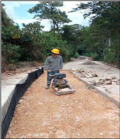
Instalación de subbase
