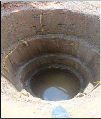
Excavación caisson
