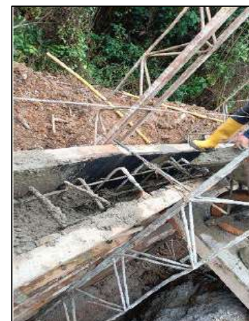
Instalación de concreto para
