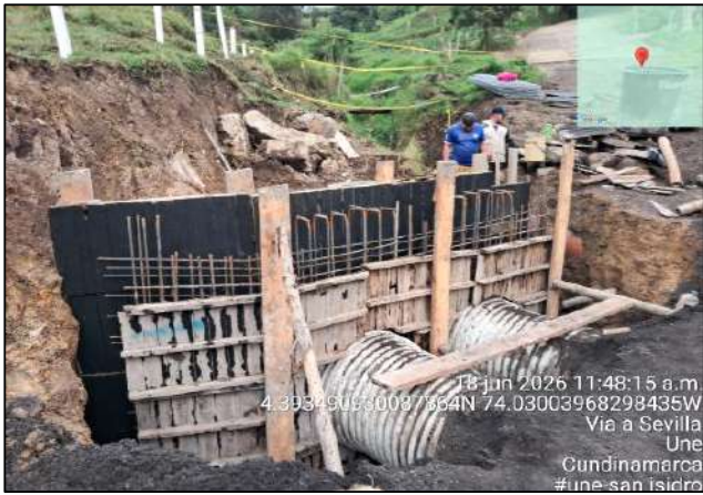
Instalación de acero cabezote
