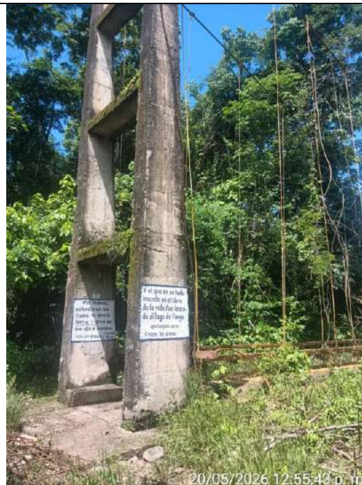
Vista general de las torre del puente metálico, la cual está conformado por concreto reforzado.
