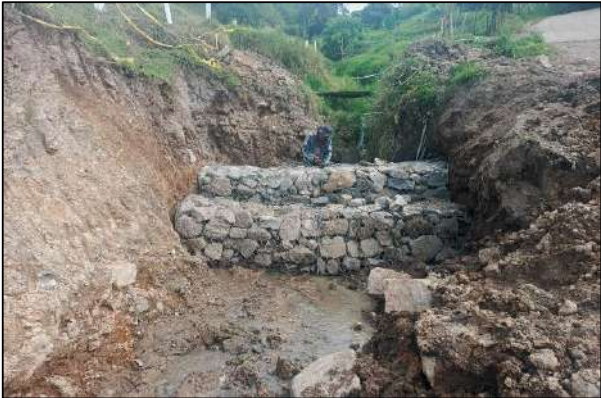
Instalación de gaviones
