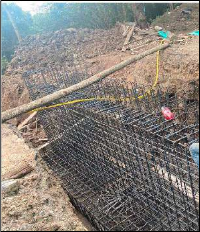
Instalación de acero para muro
