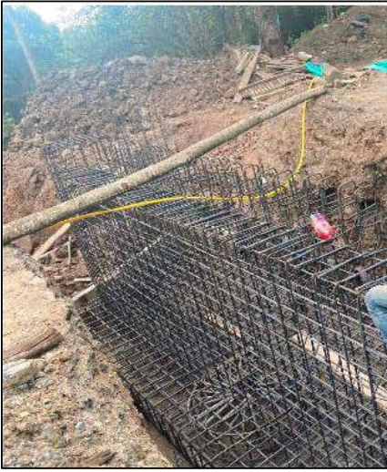
Instalación de acero estribo
