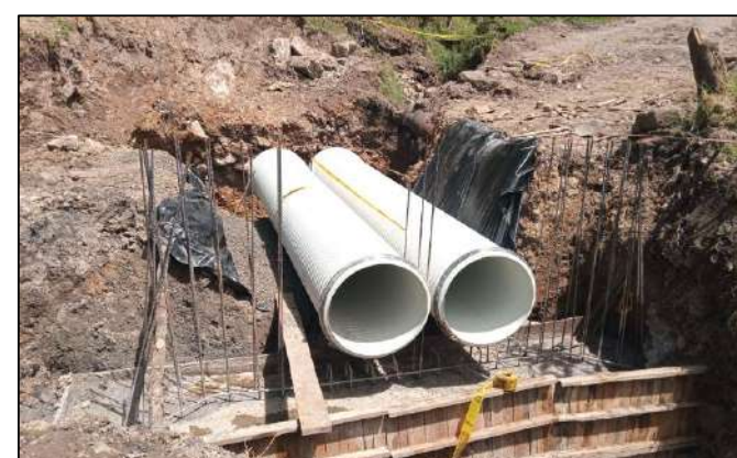
Instalación de acero para cabezote
