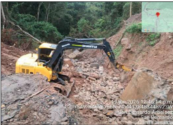
Demolición de estructura existente
