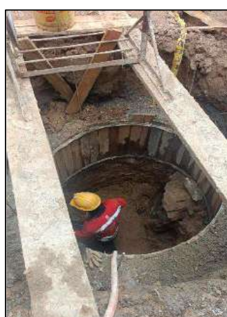
Excavación caisson
