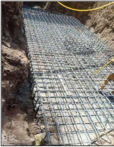
Instalación de acero estribo
