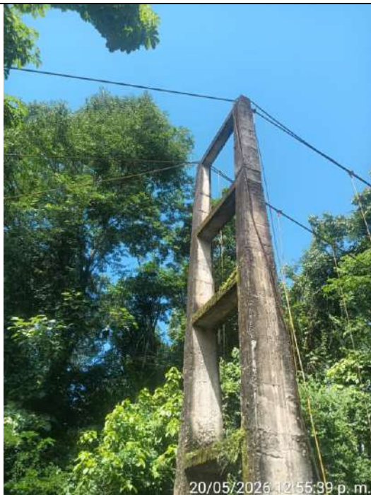
Vista general de las torre del puente metálico, la cual está conformado por concreto reforzado.
