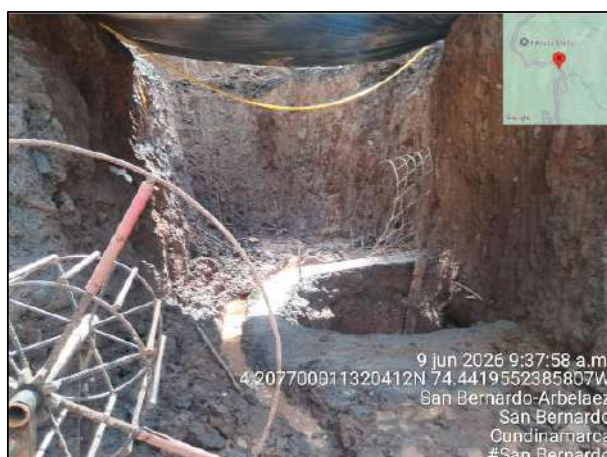
Excavación caisson
