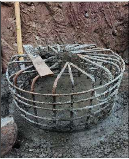
Concreto para caisson
