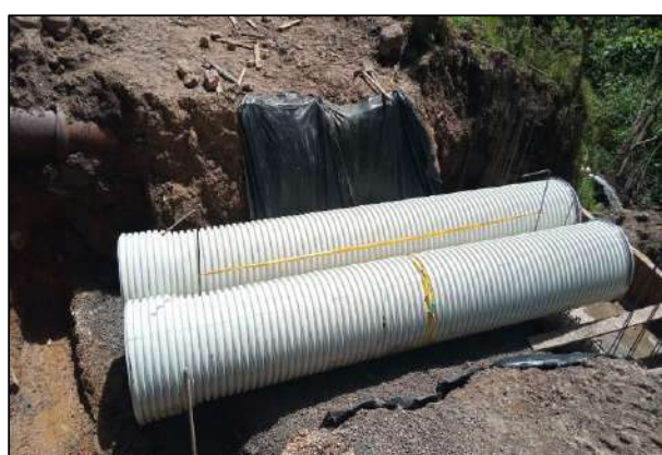
Instalación de geotexti
