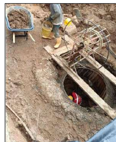
Excavación caisson
