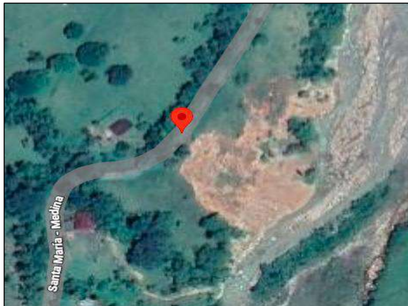
Ilustración 11. Localización del frente de obra correspondiente a sector zona B de Ubalá - Inspección Soya
