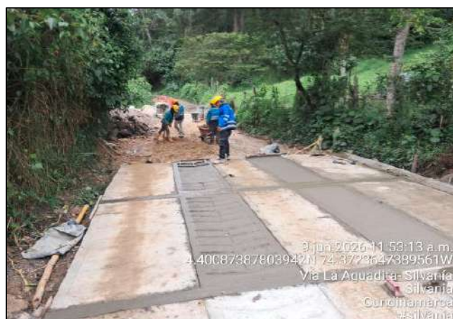
Instalación de concreto para huella
