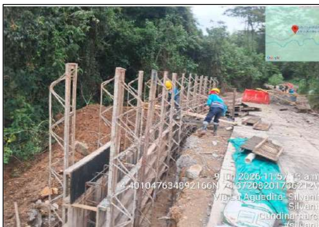
Instalación de cacero para muro
