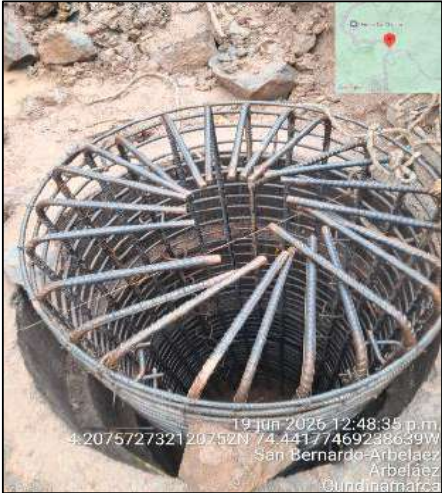
Instalación de acero caisson
